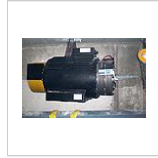
Drehstrom-Synchronmotor bei der Montage
