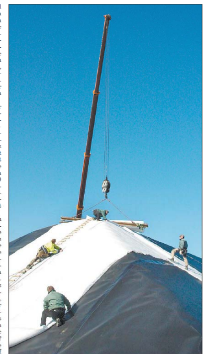
Wie Neuschnee sieht der weiße Filz auf den ersten Blick aus, den die Mitarbeiter der Bückeburger Firma Naue Sealing in vier Meter breiten Bahnen auf dem Lärmschutzwall in der Windflöte verteilen und verschweißen. Die schwarze Folie darunter ist die wasserdichte Schicht.
