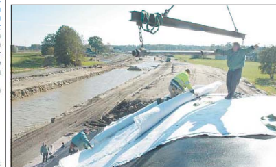
Regen und Wind erschweren das Verschweißen der Folien auf dem Wall. An dessen Fuß ist die von Niederschlägen geflutete A 33-Trasse zu sehen.
