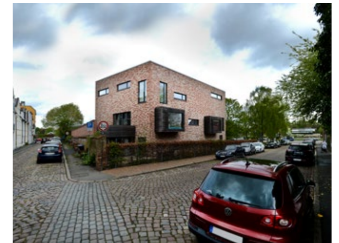
07.52 Weiter Lohberg / Ecke Wakenitzmuer mit Neubau Kita, 2020
