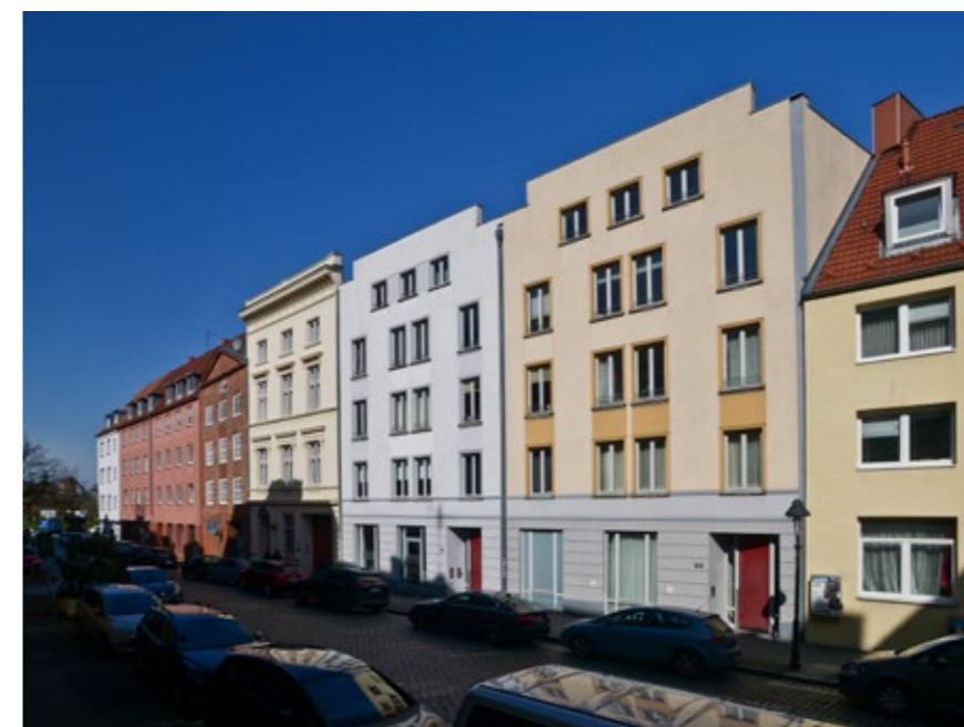
07.284 Sanierter Altbau (84) und Neubau Mehrfamilienhäuser(82 +80)
