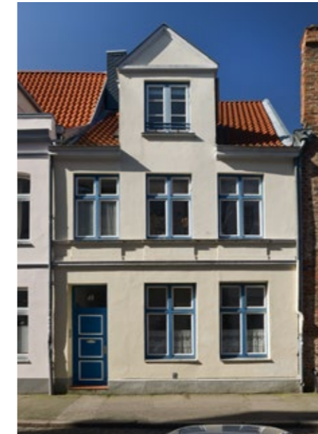
07.90 bis 07.94 Nach der Sanierung
