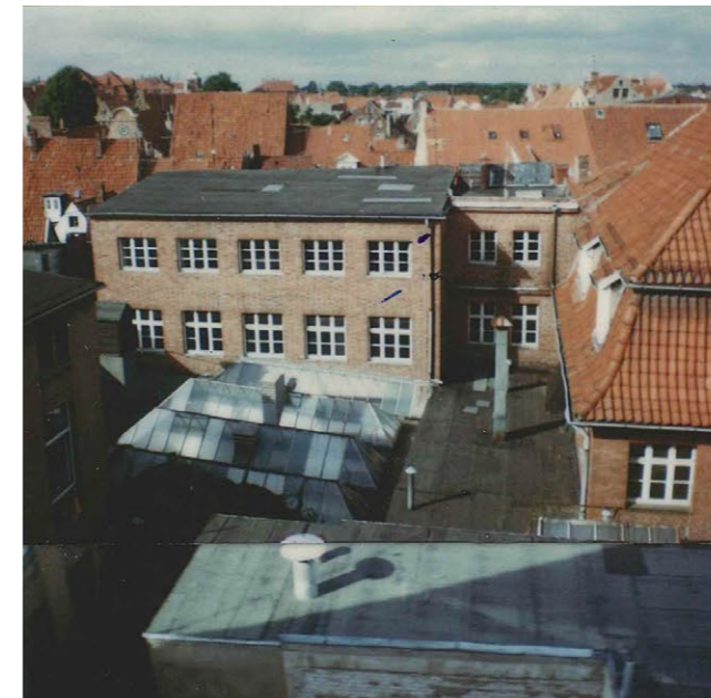
07.136 Hofsituation vor der Ordnungsmaßnahme
