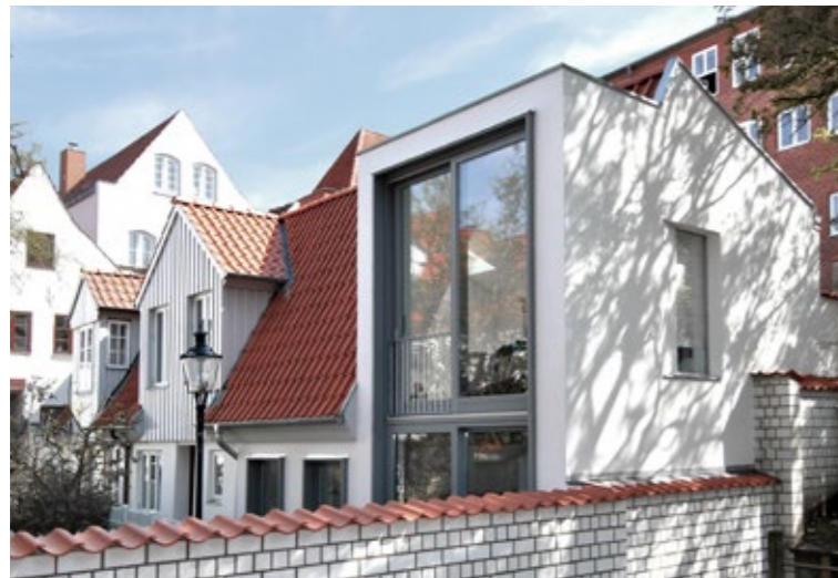
07.191 Neubau Haus Nr. 3
