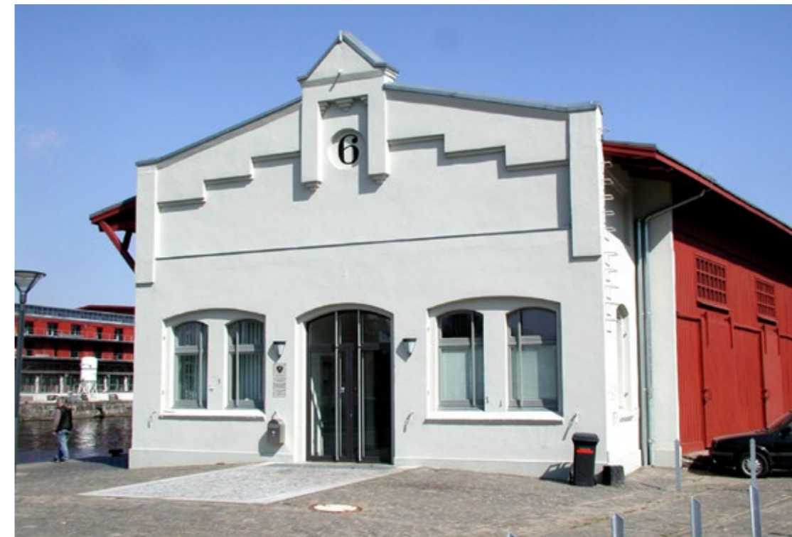
07.293 Kopfbau des sanierten Schuppen 6
