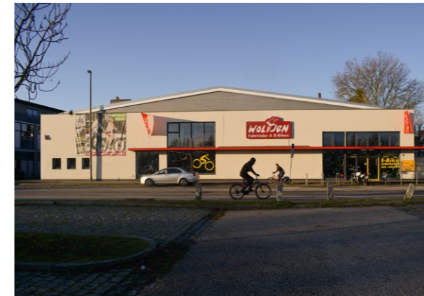
07.56 Kanalstraße 54-56 nach dem Umbau
