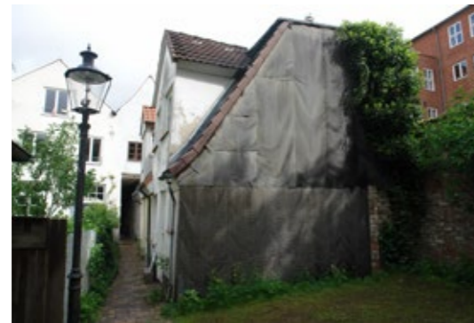
07.190 Brandwand Haus Nr. 2
