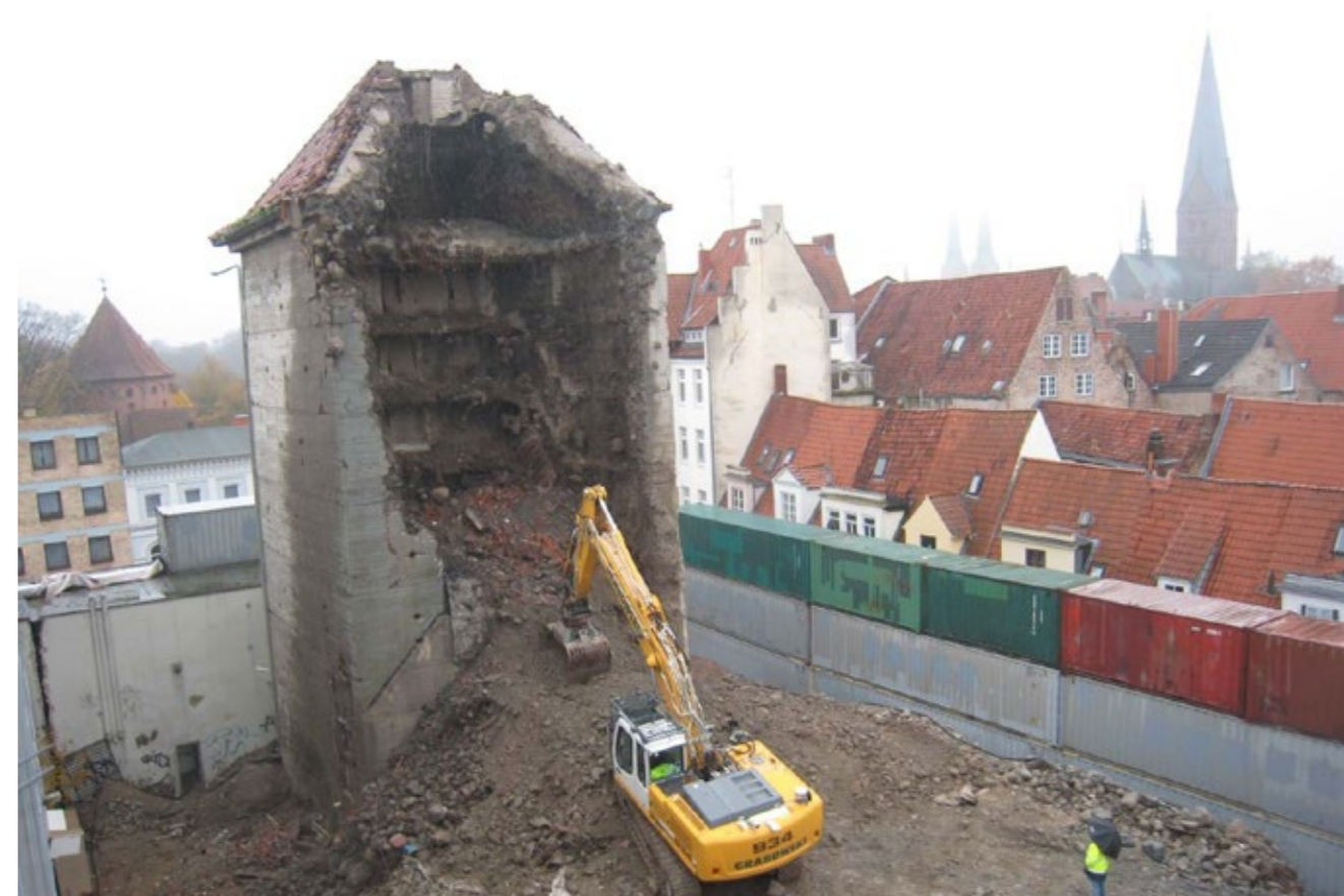
11.1 Abbruch des Aalhofbunkers 2010
