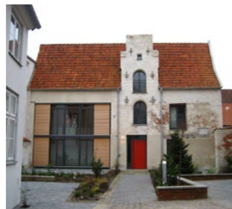
07.274 An der Untertrave 60, Saniertes Querhaus
