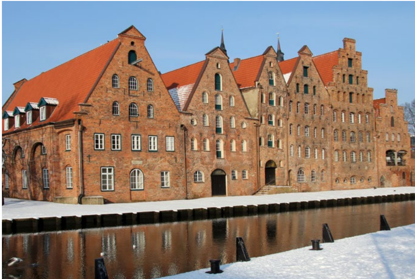
09.14 Salzspeicher- gruppe, Traveseite
