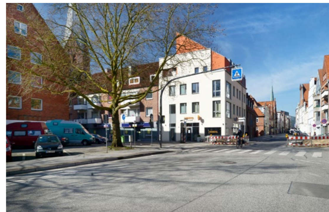
07.180 Neubau Wohn- und Geschäftshaus
