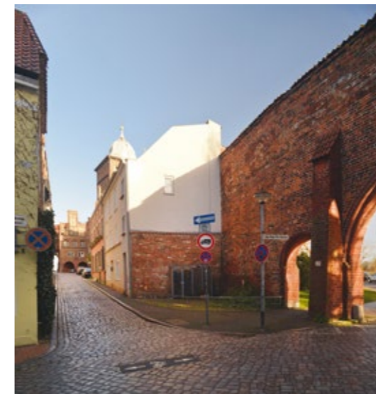
07.9 Kaiserstraße 3+5 nach der Sanierung
