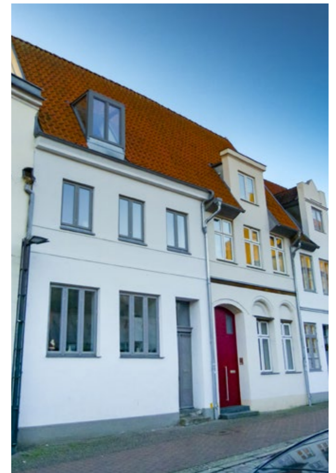
07.177 Straßenansicht nach der Sanierung
