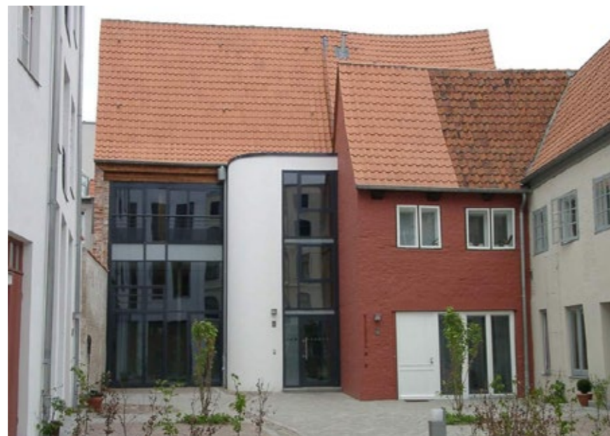
07.282 Ansicht rückwärtige Bebauung (84 c, d + e tlw.) nach der Sanierung
