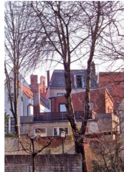
07.343 Ehemalige Hofsituation mit Anbauten
