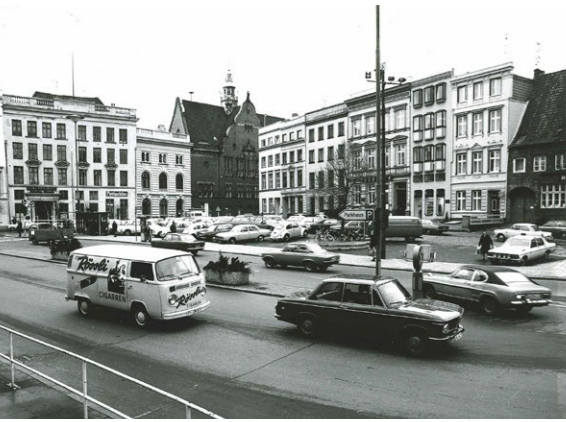
07.2 Koberg, Stand 1986, im Norden des Blockes 7 gelegen, im Hintergrund mittig die Ernestinenschule, links davon die Blockrandbebauung als südlicher Abschluss der Blockes 6
