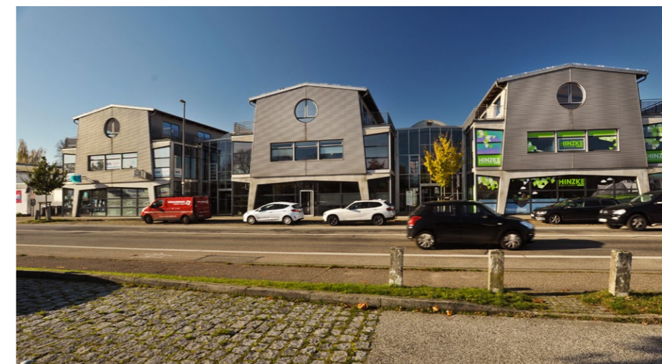
07.65 Kanalstraße 62-64, Neubau Gewerbehof
