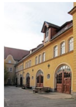
07.165 Rückseite der ehem. Wagenhalle
