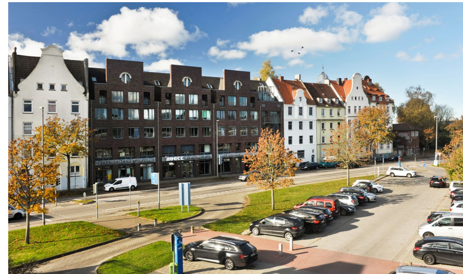
07.43 Neubau Wohn- und Geschäftshaus
