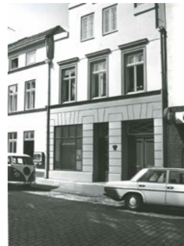
12.7 Sanierungsbüro in der Glockengießerstraße
