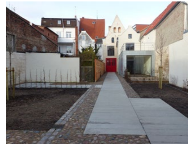
07.196 Freifläche nach Abbruch der Hofgebäude
