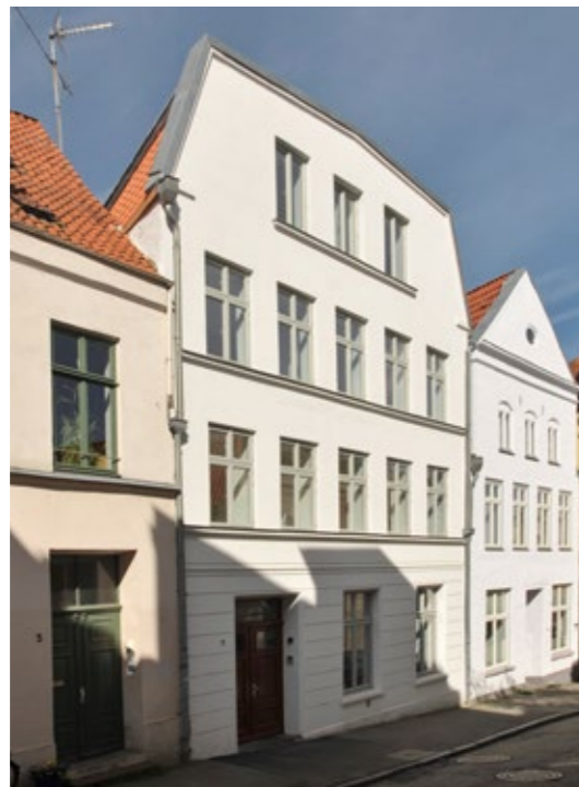
07.344 Straßenansicht nach der Sanierung
