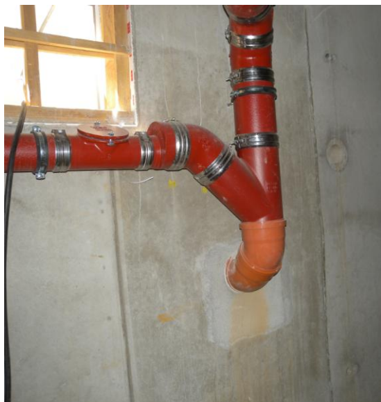
Bild 2: Beispiel für Materialwechsel in der Sammelleitung (Hausanschluss)
