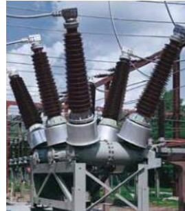
Abbildung 14: Links: Hochspannung SF 6 Live-Tank Leistungsschalter (72,5-170 kV, ABB), Rechts: Hochspannung Dead-Tank SF 6 Leistungsschalter (145 kV, Siemens).
