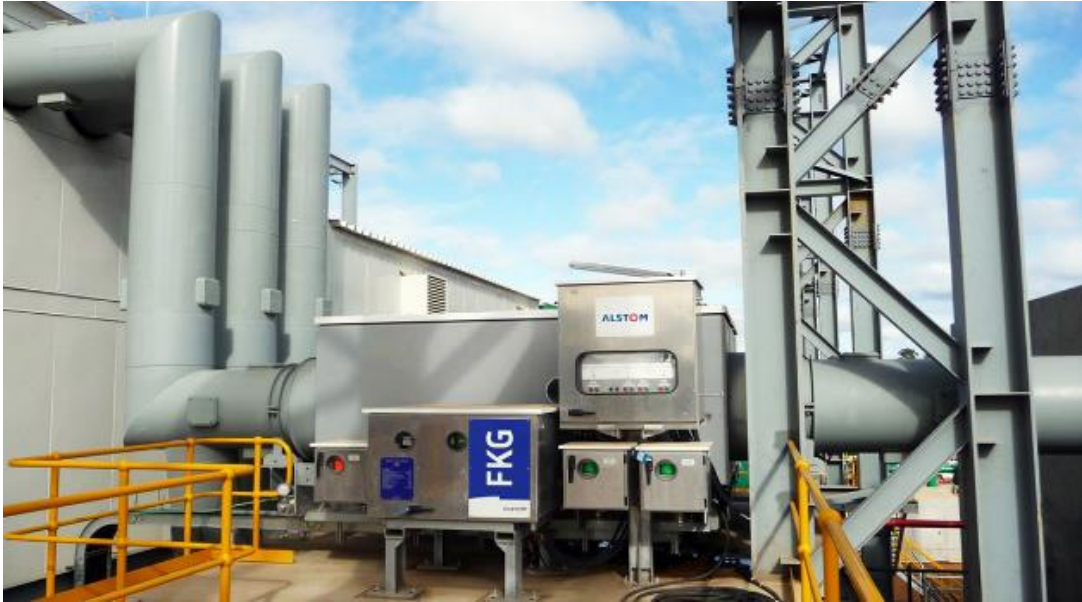
Abbildung 11: Gasisolierter Generatorleistungsschalter (Alstom)
