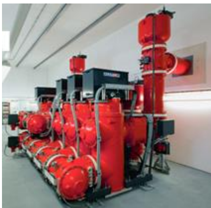
Abbildung 13: Links: 10-feldrige 110 kV gasisolierte Schaltanlage (GIS). Rechts: Querschnitt einer 72,5 kV gasisolier- ten Schaltanlage (GIS) (GE) Quelle: Produktblätter (siehe Anhang)
