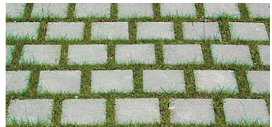
Abbildung II-20: Porenpflaster mit Gras als Befüllung
