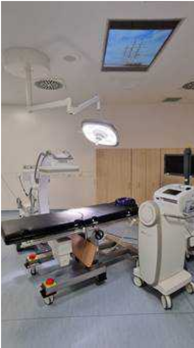
Abbildung 15: Brachytherapie-Behandlungsraum mit Patiententisch, Afterloader und C-Bogen für Kontrollaufnahmen
