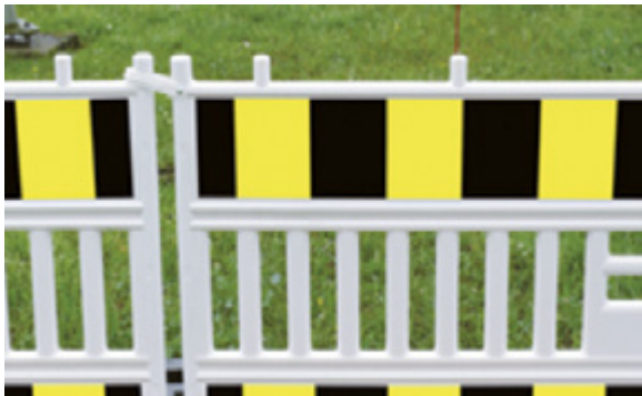
Bild 6: Verwendung von gelb-schwarz markierten Kunststoffzäunen zur Abgrenzung und Kennzeichnung des Arbeitsbereiches.
