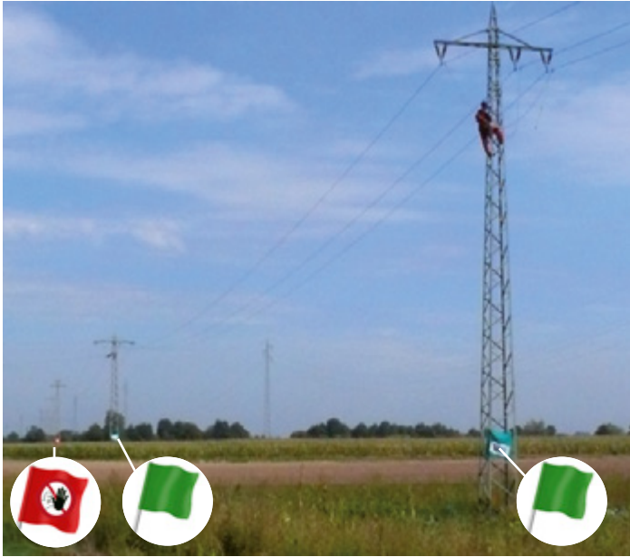
Bild 17: Bei dieser 20-kV-Freileitung sind die freigeschalteten Maste mittels grüner Flaggen gekennzeichnet. Der angrenzende Gefahrenbereich, durch die am Mastschalter anstehende Spannung, wird durch eine rote Flagge mit Verbotsschild D-P006 markiert.
