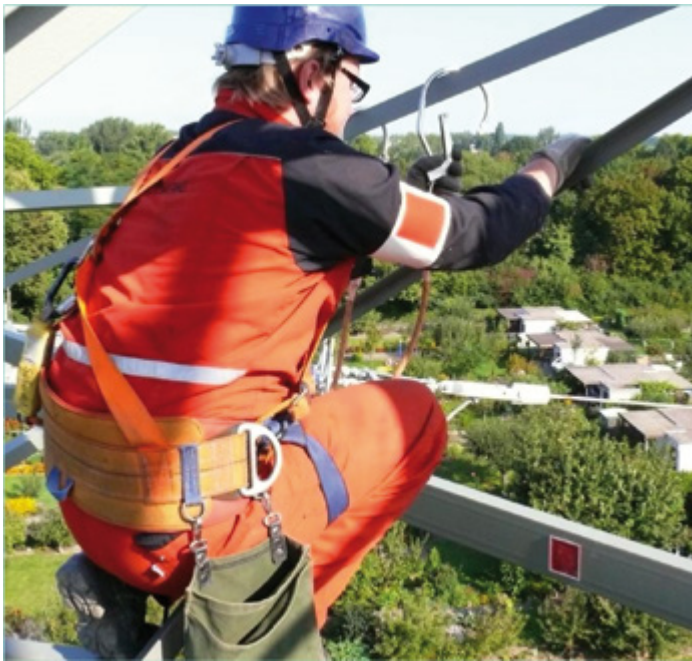
Bild 16: Durch den Einsatz von Armbinden in Kombination mit einer eindeutigen Stromkreiskennzeichnung mit Hilfe von geometrischen Formen (Schild am Masteinstieg, Traversenkennzeichnung) ist dieser Arbeitsbereich gekennzeichnet.
