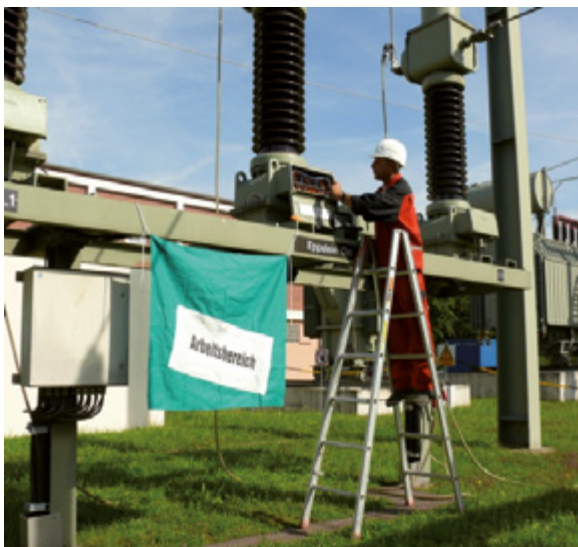
Bild 8: Beispiel zur Kennzeichnung des Arbeitsbereiches mit grüner Flagge.
