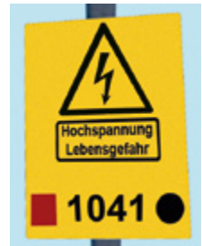
Bild 16: Durch den Einsatz von Armbinden in Kombination mit einer eindeutigen Stromkreiskennzeichnung mit Hilfe von geometrischen Formen (Schild am Masteinstieg, Traversenkennzeichnung) ist dieser Arbeitsbereich gekennzeichnet.
