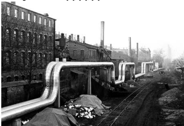
Bild 1.1 Fernwärme, Leipzig 1986, DDR [4].
