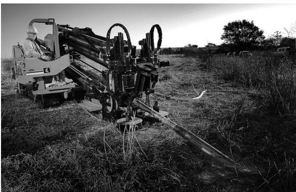
Bild 4.20 Spülbohrmaschine im Einsatz.
