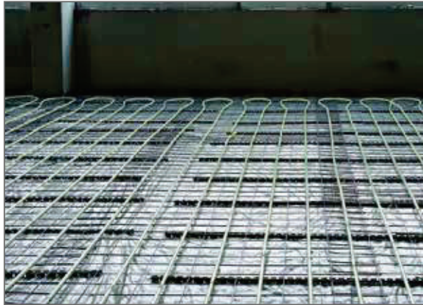
Abb. 227: Fonterra Industry Verlegebeispiel
