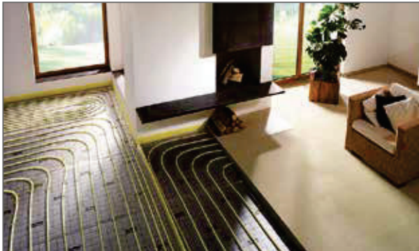
Abb. 80: Flexibles Tackersystem für Flächenheizung und Flächenkühlung
