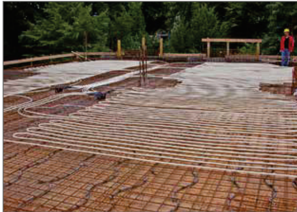
Abb. 212: Fonterra Active Baustellenfoto
