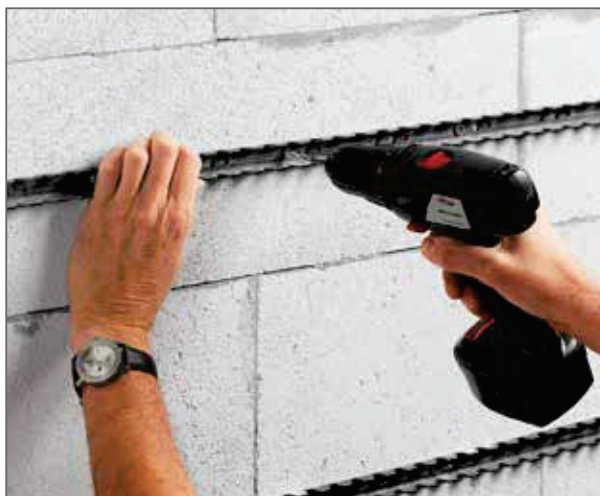
Abb. 186: Befestigung der Klemmschienen
