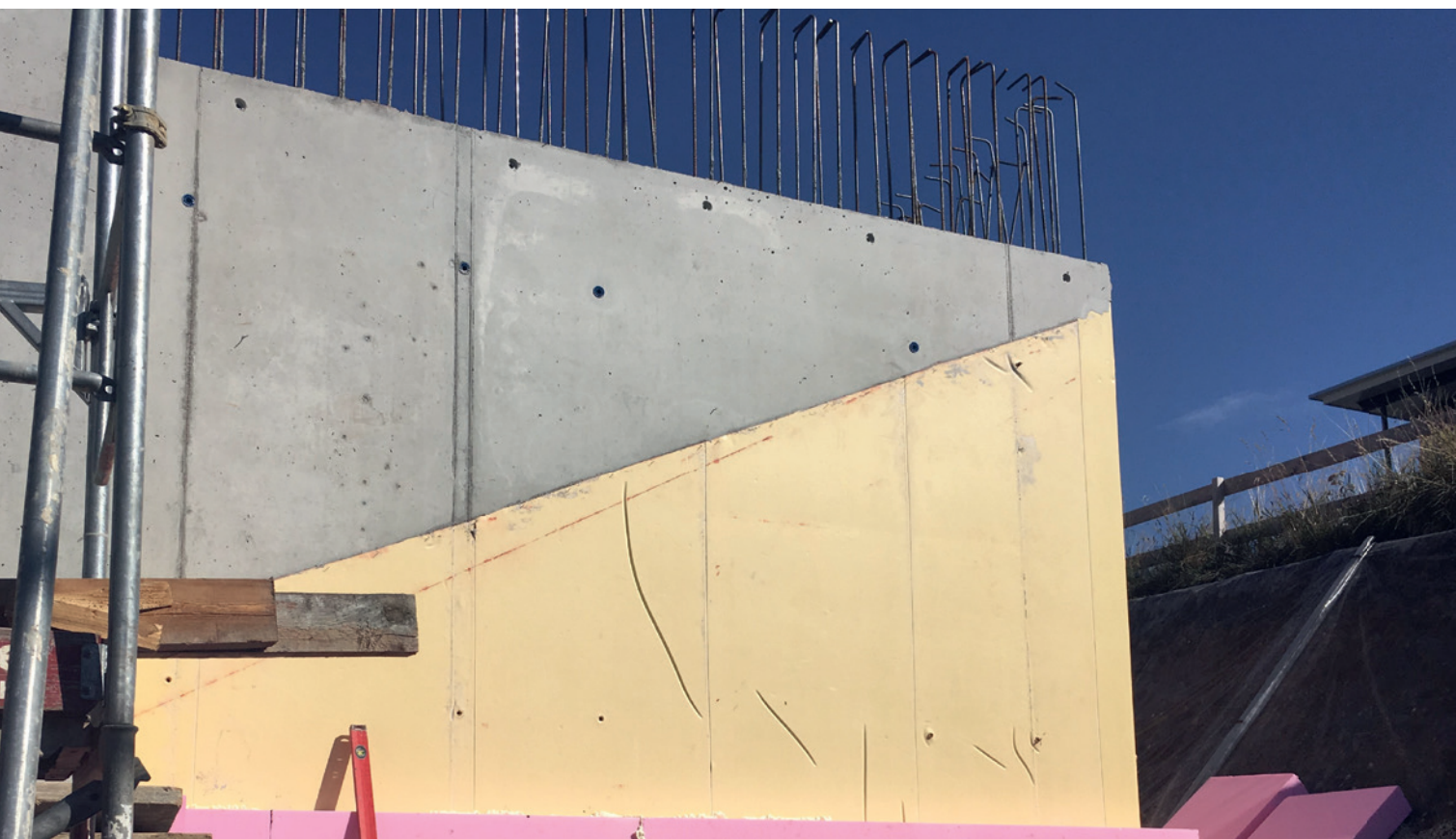
Mur avec membrane FPO partielle.
