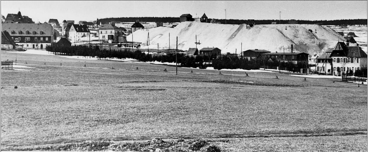
Abbildung 15: Versickerungsfläche B unter und neben der später wieder abgetragenen Wäschanlage bis zum Goetheweg, links Gasthaus Sächsischer Reiter, rechts Direktorenvilla der Stahlwerk Becker AG (heute Geisingstraße 4, dahinter verläuft der Goetheweg), dazwischen Baracken des Kriegsgefangenenlagers, Foto 1918 [Stahlwerk Becker AG (1918)]
