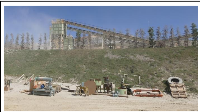
Primärbrecher, Wolframgrube Los Santos (Spanien)
