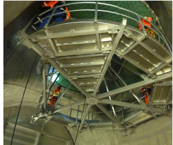
Abbildung 8: Gestaltung des Schachtkopfes für die Einführung von Frischwettern und die Aufnahme einer Notfahrgangseinrichtung
