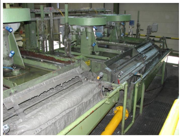
Flotationsanlage, Wolframgrube Mittersill (Österreich)
