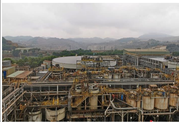
Kompakte Sulfidflotationsanlage, dahinter Eindicker, Wolframbergbau Nui Phao Nordvietnam 2020
