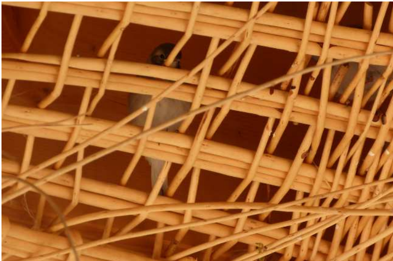
Das Dach des neuen Beobachtungsturmes bietet Bachstelzen ideale Brutmöglichkeiten. Hinter dem Weidengeflecht des Unterdaches sind die Vögel optimal vor Witterung und Feinden geschützt (Foto: Hans Schmid, 20.5.2014). Der Brutplatz war 2014 und 2015 besetzt.
