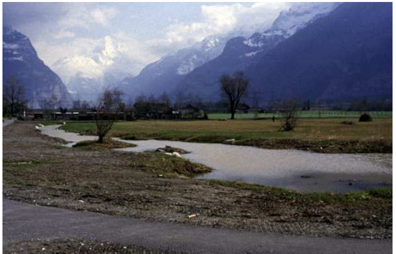
Der Fischgraben ist im Winter 2002/03 neu gestaltet worden. Noch präsentiert sich das Gelände sehr vegetationsarm und offen (Foto: Hans Schmid, 2003).
