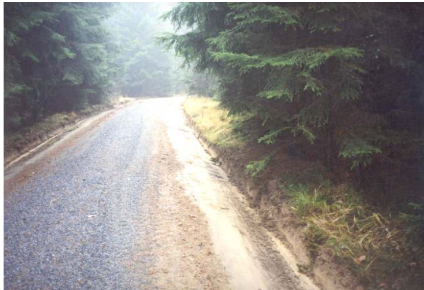
Ergebnis der Instandsetzung eines Grabens mit dem Grabenbagger
