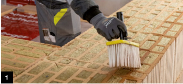
1 Ziegeloberfläche entstauben und anfeuchten
