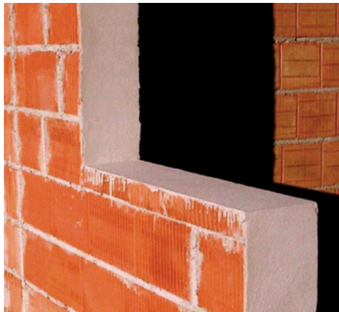
Laibung und Parapet mit Glattstrich
