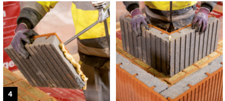
4 Deckenrandschale im Eckbereich auf Gehrung schneiden und verkleben
