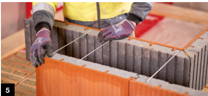
5 Montagebügel zur Lagesicherung einsetzen (2 Stk./lfm)
