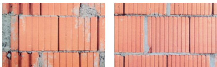
Mit Mörtel geschlossene Fehlstellen Vermörtelung einzelner Stoßfugen
