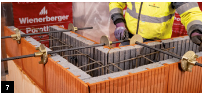
7 Schalungsanker zur Sicherung gegen Betondruck anbringen, anschließend ausbetonieren und verdichten des Betons
