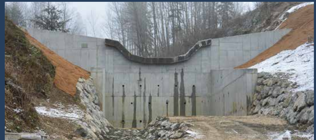
Abb. 4: Die fertiggestellte Konsolidierungssperre kurz nach Abschluss der Bauarbeiten
