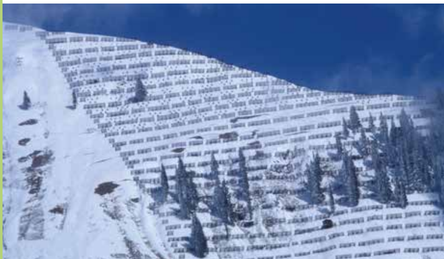
Abb. 8: Verschiedene Methoden des Gleitschneeschutzes
