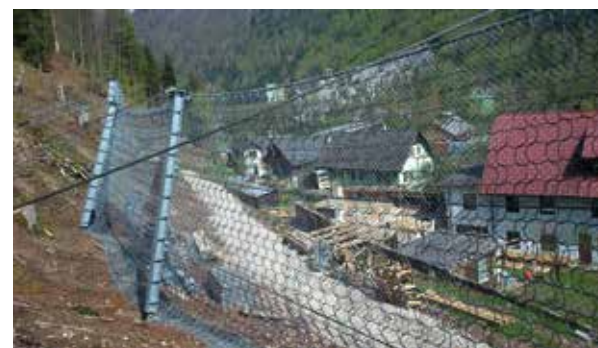
Abb. 9: 2015 fertiggestellte Steinschlagschutzverbauung Bannwald Gstättenberg Bad Ischl
