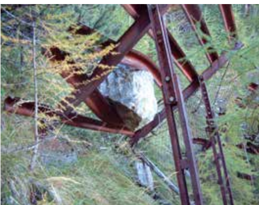
Abb. 10: Zerstörtes Schneenet durch Steinerschlag (links), Beschädigtes Stützwerk aus Stahl (rechts)
