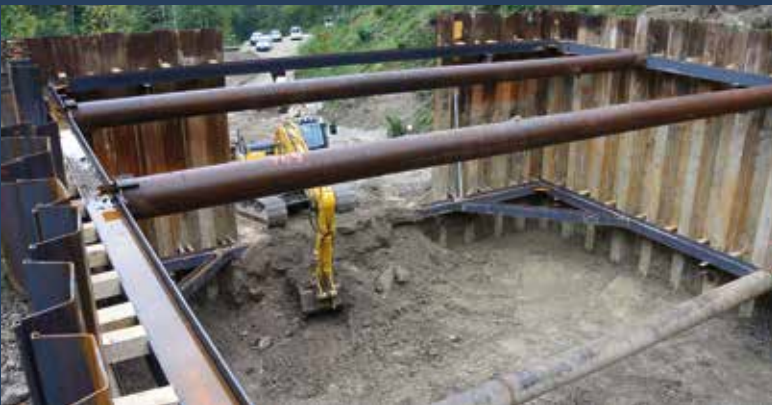
Abb. 1: Die Spundwandsicherung mit den zwei Aussteifungsebenen kurz vor Abschluss der Aushubarbeiten
