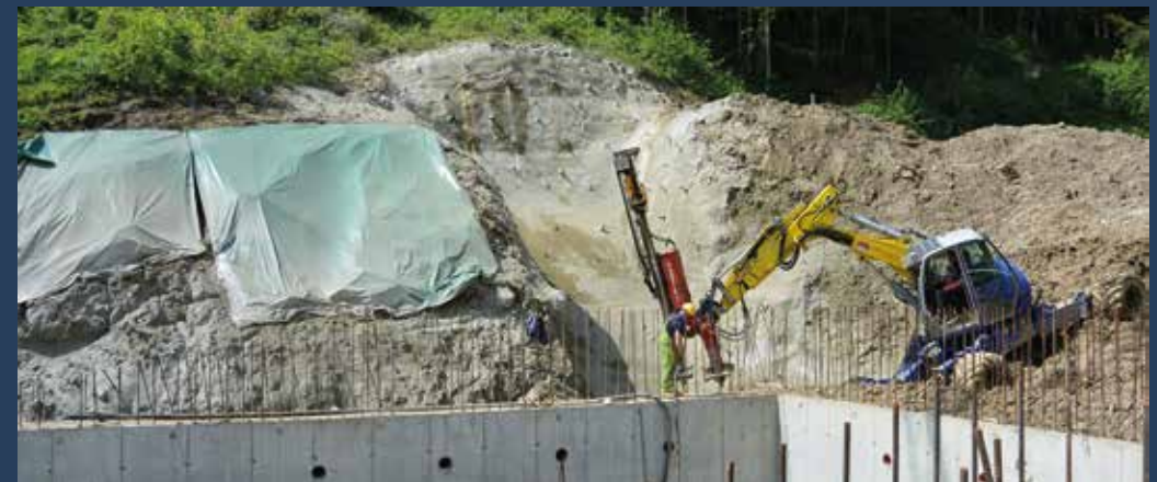
Abb. 3: Der 1. Bauabschnitt mit der Aushubsicherung der Flügel mittels Spritzbeton-Nagelwand
