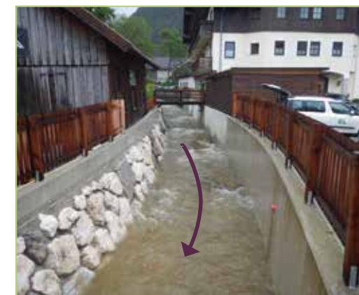
Abb. 7: Beispiel Eibenseebach im hm 2.6 bei 1.4 m 3 /s Abfluss; Profilgeometrie, Fließgeschwindigkeiten sowie Durchflussmenge je Messlotrechte
