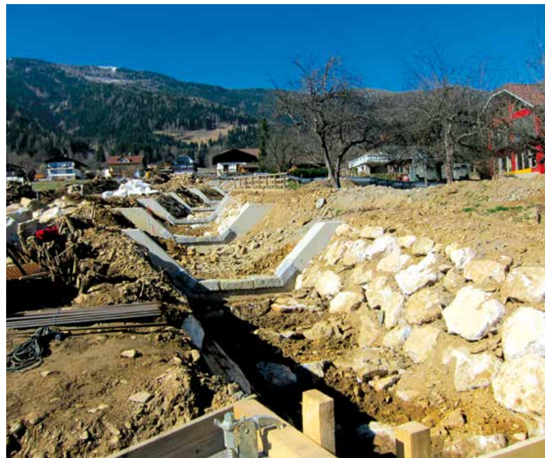
Abb. 12: Grobsteingerinne und Grundschwelen in Beton im Unterlauf bis zur Geschiebedosiersperre hm 10,81
