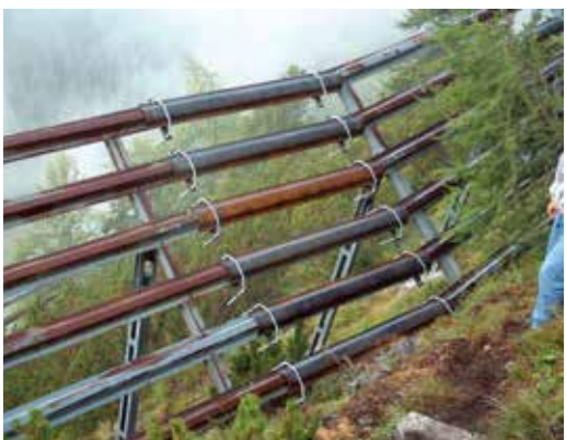
Abb. 9: Schließen von Lücken in den Werksreihen
