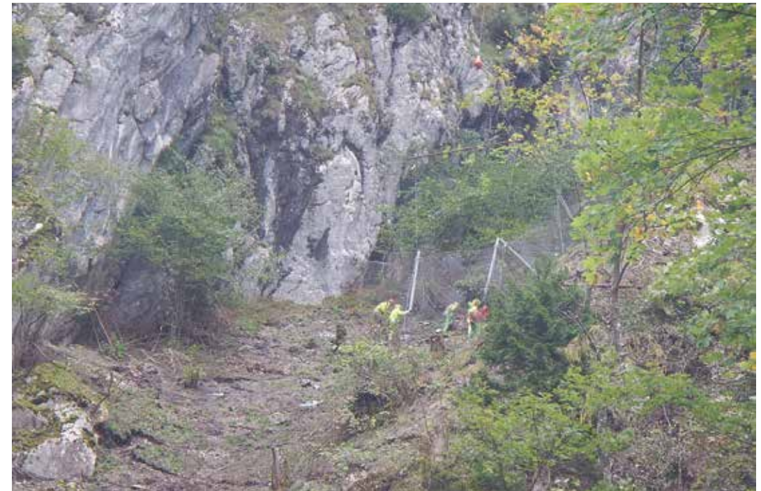
Abb. 4: Bannwald Sonnstein Teufelsgraben, Montage von Schneenetzen
