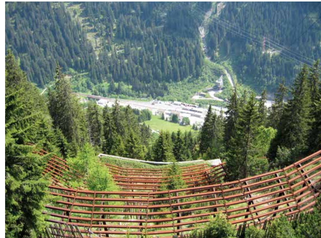
Abb. 2: Schutzwald mit Lawinenanbruchverbauungen, Langen a. Arlberg
