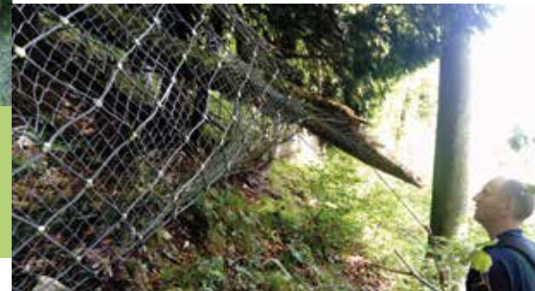
Abb. 8: Bannwald Bürgelstein St. Wolfgang, nach einem Windwurf 2017 wurden zahlreiche Blöcke und Stammteile vor Eintritt in das Areal des unterliegenden Bundesinstitutes für Erwachsenenbildung durch die hergestellten Schutzmaßnahmen zurückgehalten.
