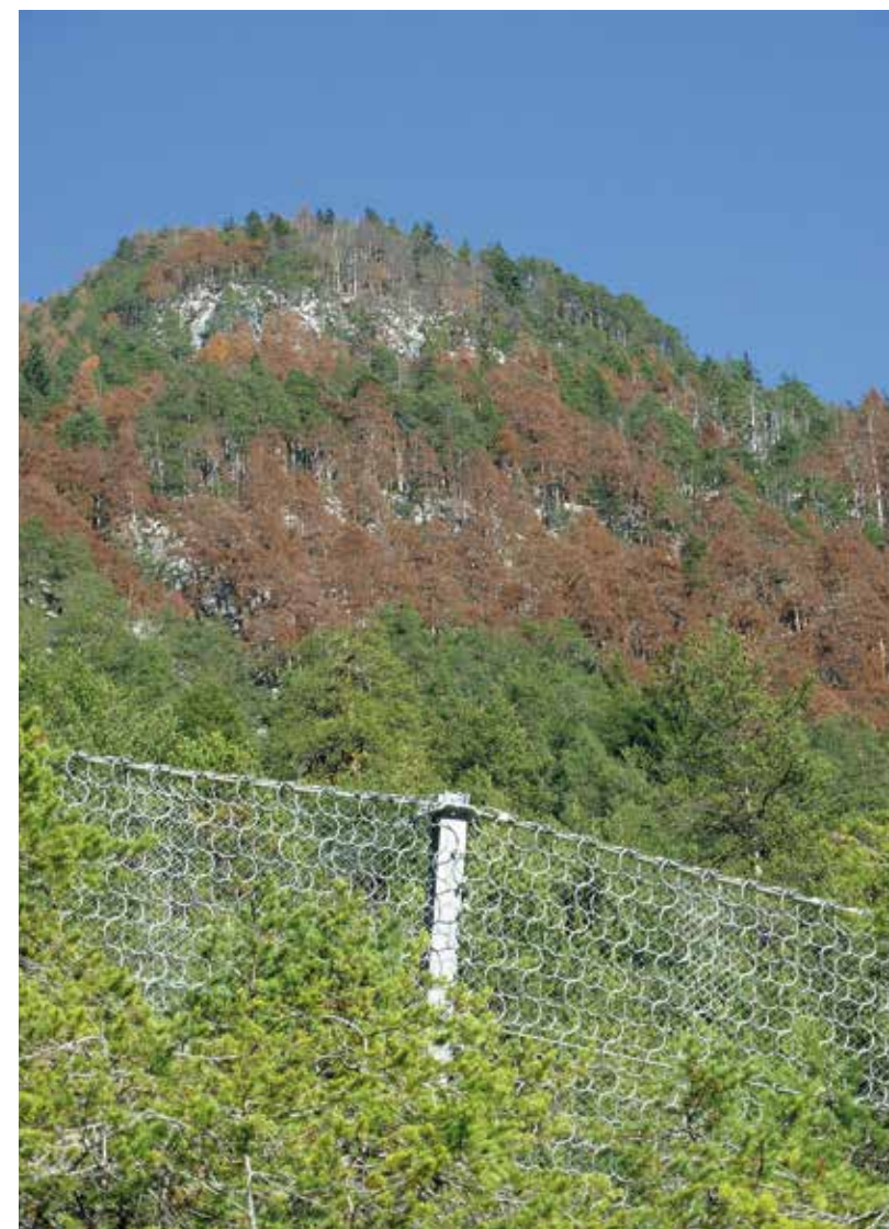
Abb. 4: Eine Massenvermehrung des Sechszähligen Kiefernborkekäfers führte zu groß-flächiger Baummortalität auf einem Schutzwaldstandort. Schutzzäune mussten errichtet werden, um die verlorene Steinschlagschutzwirkung zu kompensieren. BFW Praxisinformation Nr. 34 – 2014, Bad Bleiberg (Foto: BFW/Tomiczek, Cech, Hoch, 2014)
