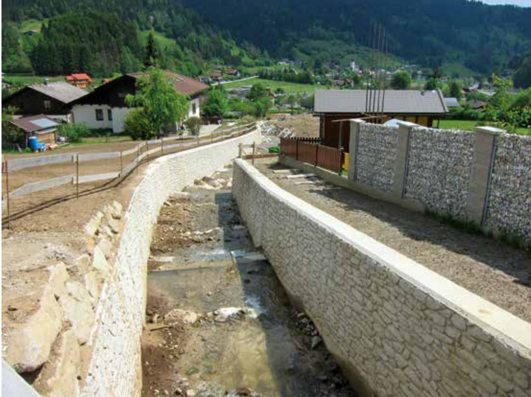
Abb. 13: Beidseitige Leitwerke mit Strukturschalung im beengten Ortbereich Kraa
