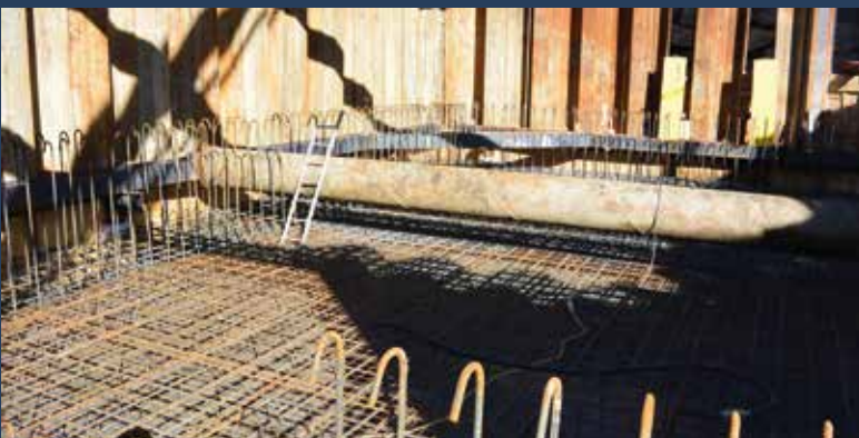
Abb. 2: Die Plattengründung mit der unteren Aussteifungsebene, welche nach Fertigstellung und Funktionsübergabe an diese entfernt wurde
