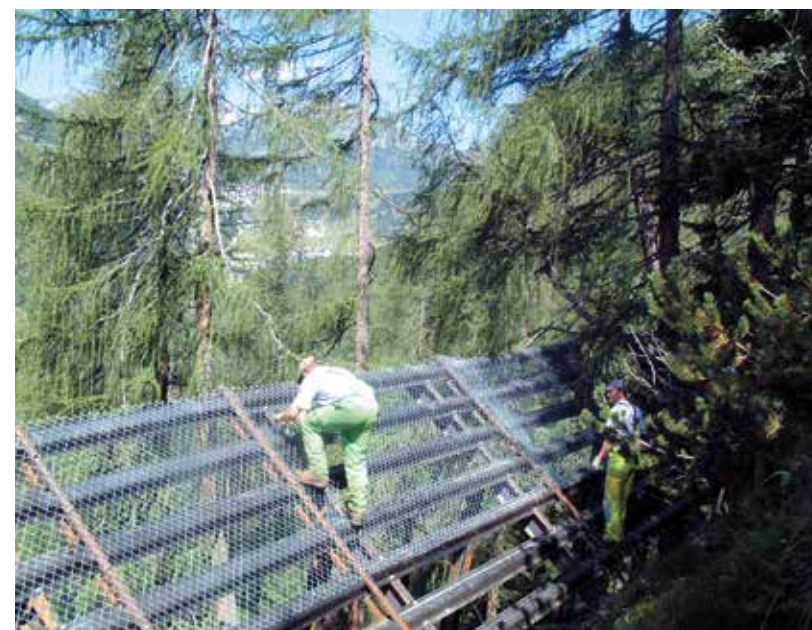
Abb. 11: Staublavinablagerung im Postknechtgraben (oberes Bild), Geflechtauflage (unteres Bild)
