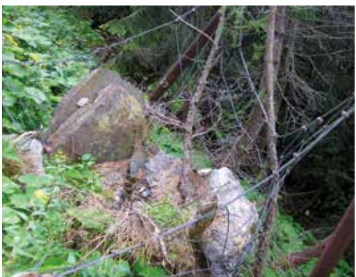
Abb. 10: Zerstörtes Schneenet durch Steinerschlag (links), Beschädigtes Stützwerk aus Stahl (rechts)
