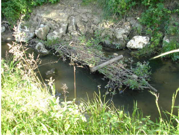
Abb. 5 Totholzeinbau Musterstrecke
