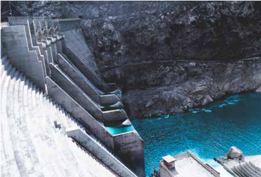
Staumauer des Wasserkraftwerks Cerro del Águila in Peru. (Bild: Andritz)
