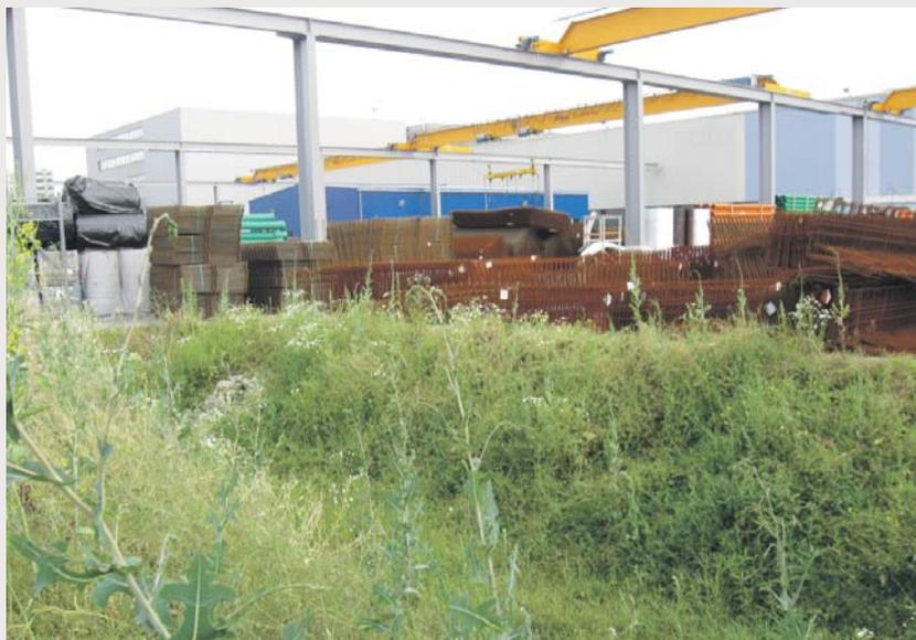
Das Regenwasser des grossen asphaltierten Lagerplatzes der Firma Acifer in Regensdorf fliesst via Einlaufschächte und Sammelleitungen in eine Versickerungsmulde am Rand der Parzelle, wo es versickern kann.
