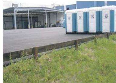
Das Regenwasser fliesst auf der grossen Platz- und Lagerfläche der Firma TOI TOI in Buchs (ZH) oberflächlich in die Versickerungsmulde.
