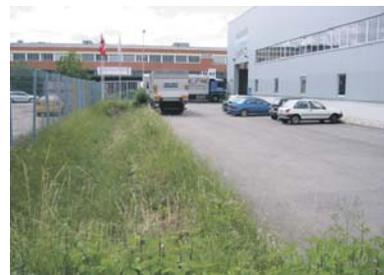
Der Grünstreifen zwischen Parzellengrenze und Platzfläche ist bei der Stahl-Contor in Embrach als Versickerungsmulde ausgebildet: eine sinnvolle Doppelnutzung eines Randstreifens als Grün- und Versickerungsfläche.
