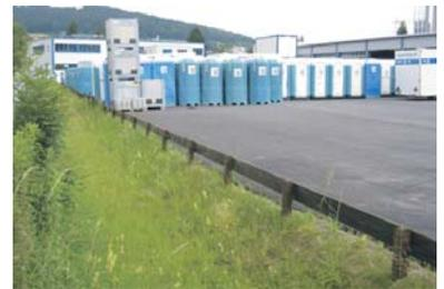
Der grosse Verkehrs- und Lagerplatz der Firma TOI TOI in Buchs (ZH) wird ohne Einlaufschächte und Sammelleitungen entwässert. Das Regenwasser fliesst über die Belagsfläche in die Versickerungsmulden. Diese Entwässerungsart zahlte sich bei den Baukosten aus, konnten doch damit ca. Fr. 30'000 eingespart werden.
