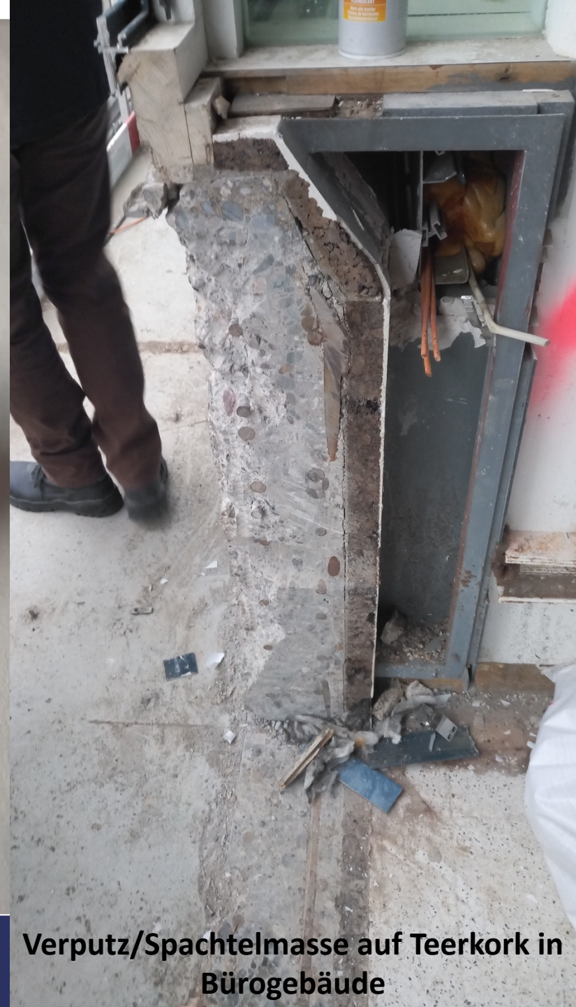
Verputz/Spachtelmasse auf Teerkork in Fenster­nische
