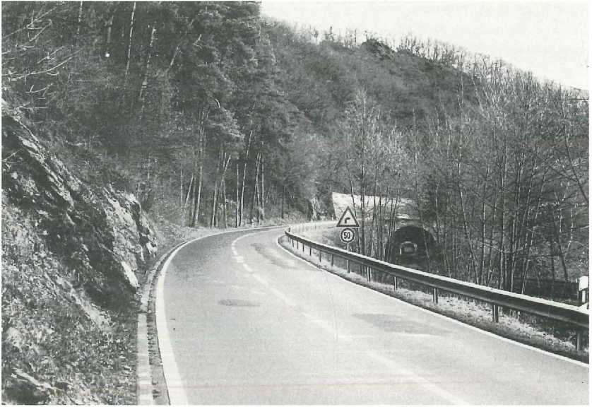
Abb. 13: Bei 3,75 km gelegener Streckenabschnitt mit auffällig hohen Amphibien-Fundzahlen. Die Straße überquert an dieser Stelle das Portal eines Eisenbahntunnels. Wenige Meter weiter rechts befindet sich das Lahnufer. Foto: Verf.
