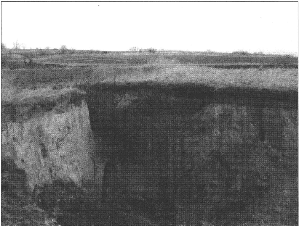
Abb. 5 Durch Sackungen freigelegte Hohlräume im Löß
