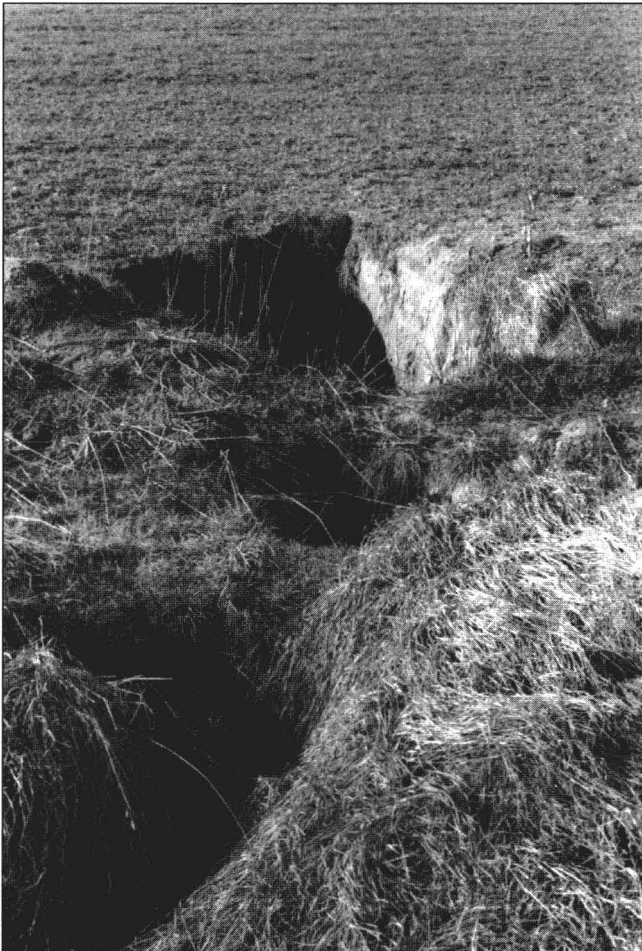
Abb. 4 Eingestürzte Tunneldecke im Löß
