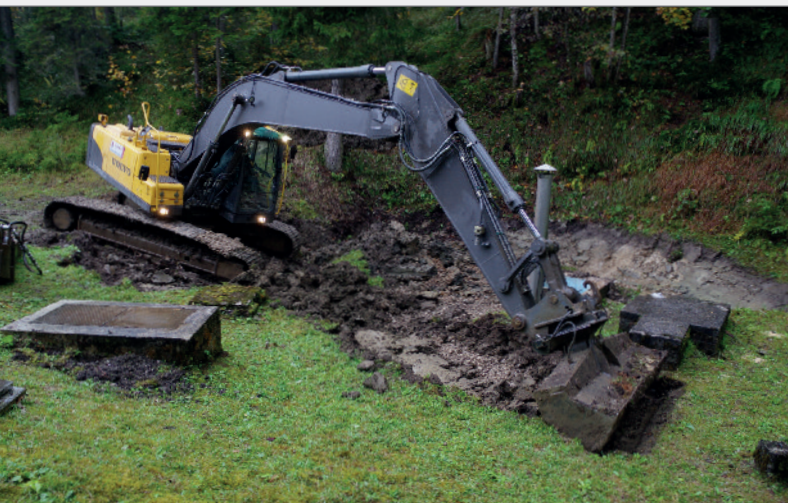
Abb. 11: Beginn der Renaturierungsarbeiten am 4.10.2016. Freilegung der Stahlbetondecke. Foto: Robert Seebacher Fig. 11: The beginning of the renaturation on October 4, 2016 and exposure of the concrete ceiling.
