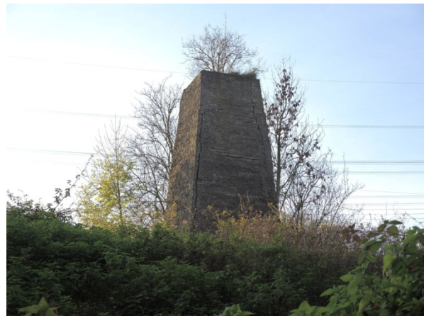
Abb. 19: Widerlager der Seilbahn von der Henrichshütte zur Zeche Friedlicher Nachbar (T. KASIELKE).
