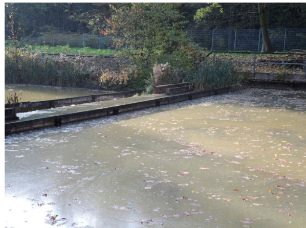
Abb. 20 & 21: Absetzbecken der Grubenwasserhebung von Friedlicher Nachbar (T. KASIELKE).
