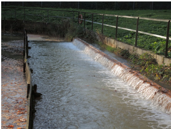
Abb. 20 & 21: Absetzbecken der Grubenwasserhebung von Friedlicher Nachbar (T. KASIELKE).
