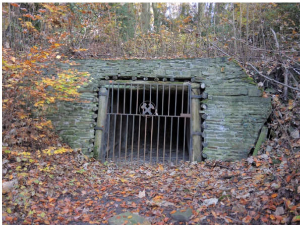
Abb. 13: Rekonstruiertes Stollenmundloch der Zeche Dickebaeckerbank (T. KASIELKE).
