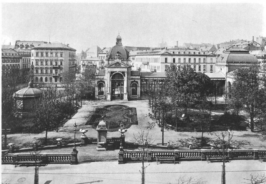
Abb. 19: Kochbrunnenanlagen, Zentralbau mit französischer Kuppel. Fotografie, um 1930.
