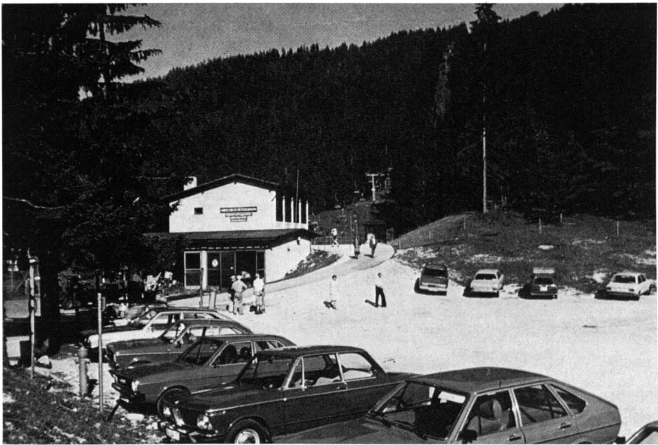
Abb. 27 An Parkplätzen ist die äußere Eingrünung sowie die innere Strukturierung mit Pflanzungen teilweise noch mangelhaft. (Foto: Wörnle)
