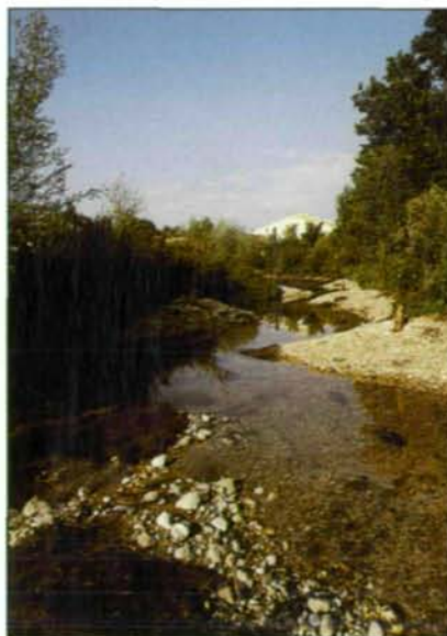
Abb. 6: Die Schottervorschüttungen und kleinen Inseln beim Weidingerbach, wie sie dieses Bild, das 1989 kurz nach Fertigstellung der 1. Phase der Renaturierung aufgenommen wurde, zeigt, sind im Laufe der Jahre durch Hochwässer zum Teil wieder abgetragen worden.
