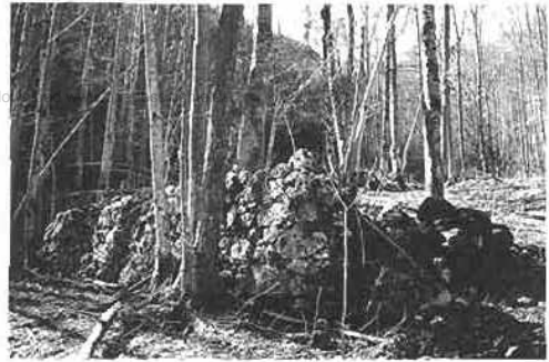
Mauerreste der Aufbereitungsanlage.
