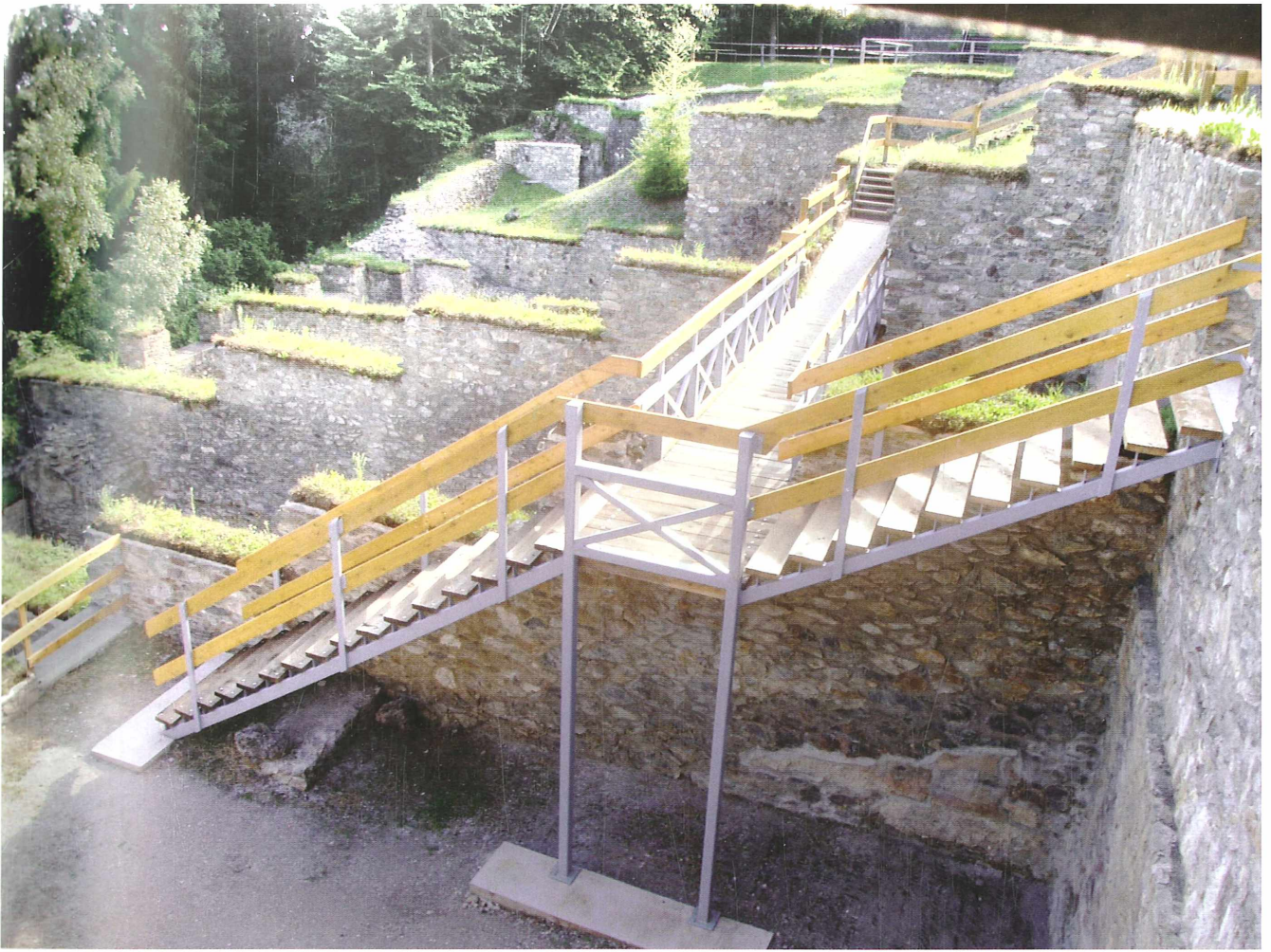
Abb. 3: Treppenkonstruktion in AA/43; Blick aus Nordosten. Aufn. H. Dolenz
