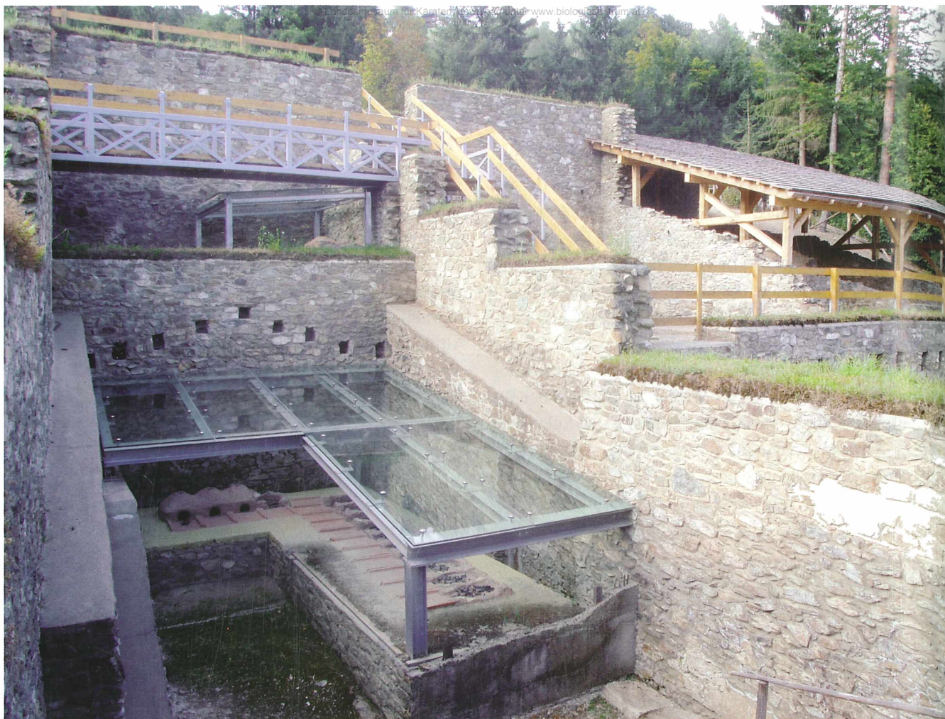
Abb. 2: Brückentragwerk über AA/41A; Blick aus Südwesten. Aufn. H. Dolenz
