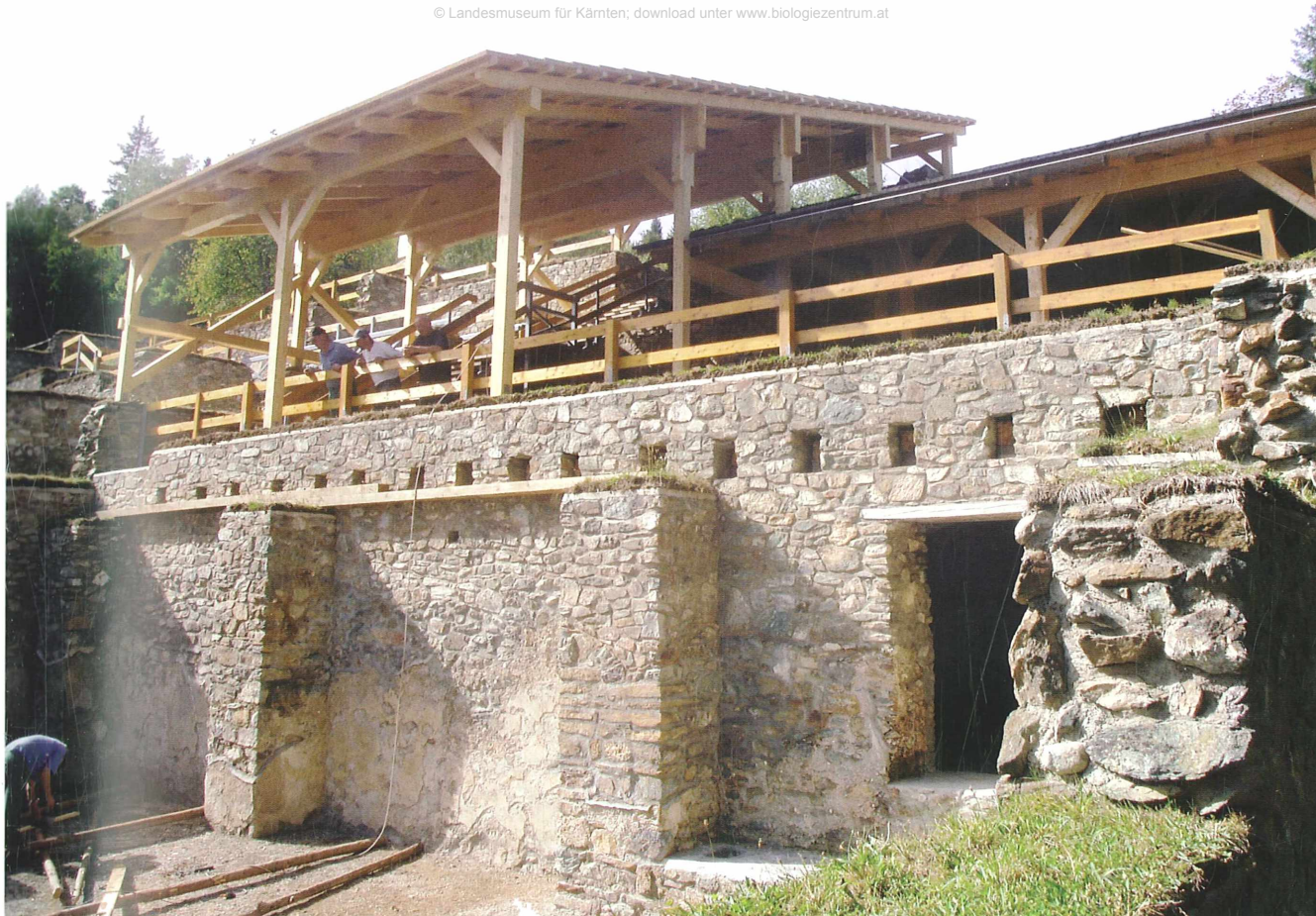
Abb. 5: Schutzdach über Raum AA/43; Blick aus Südosten. Aufn. H. Dolenz
