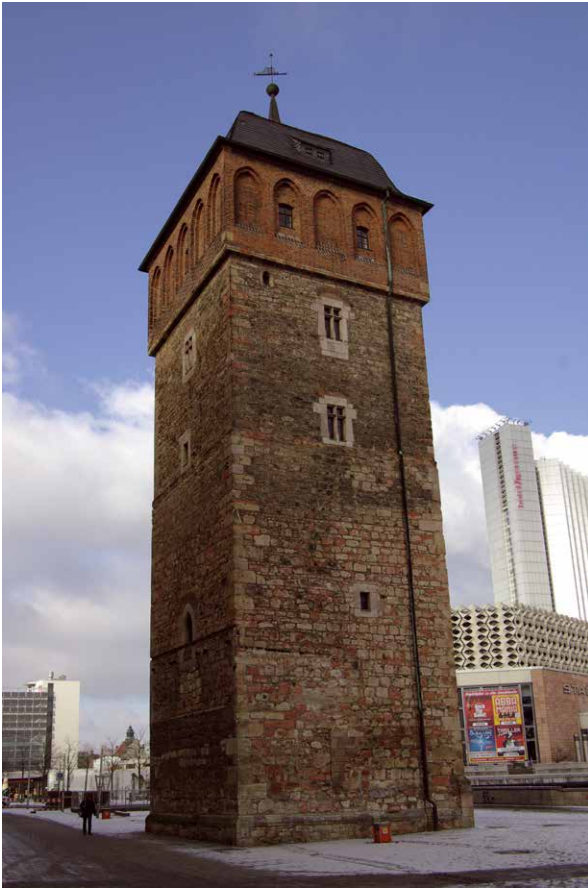
Abb. 11 Roter Turm mit mittelalterlichem Mauerwerk aus Hilbersdorfer Porphyrtuff.
