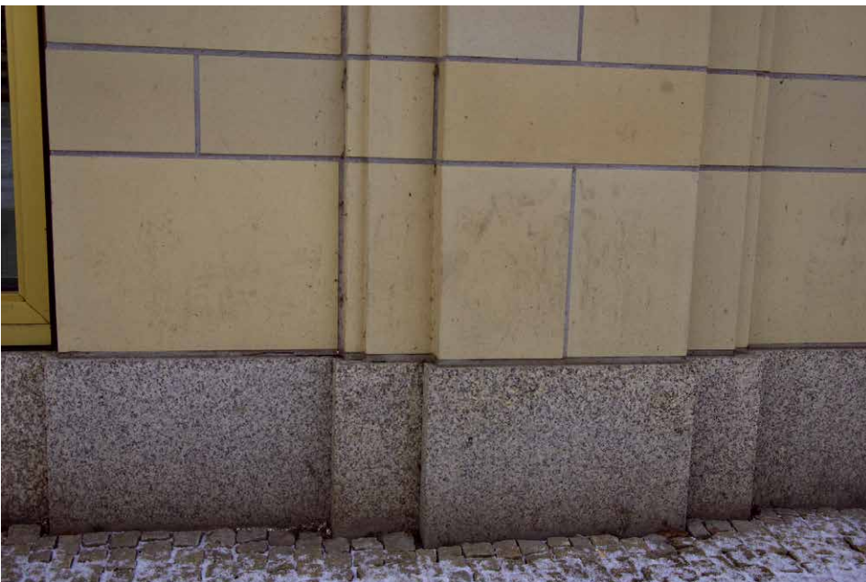
Abb. 19 Moderne Fassadengestaltung an der Galerie am Roten Turm (Am Wall) mit Keramikelementen, die auf Fernsicht eine Natursteinoptik vortäuschen, und Granit in der Sockelzone.
