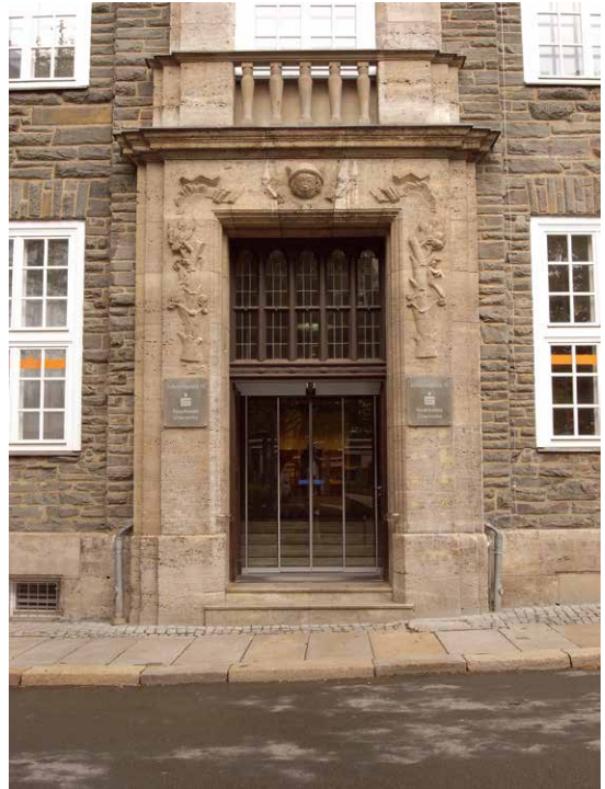
Abb. 14 Eingangsbereich am Gebäude der ehemaligen Dresdner Bank (erbaut 1922-1924) mit Muschelkalk in der Portalzone und Chloritschiefer in den Wandflächen.
