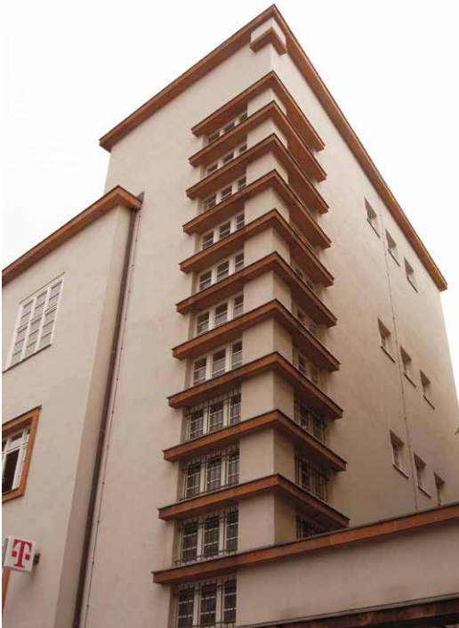
Abb. 13 Gliederungselemente aus Rochlitzer Porphyrtuff am Telefonamt Chemnitz-Mitte, erbaut 1928/29.
