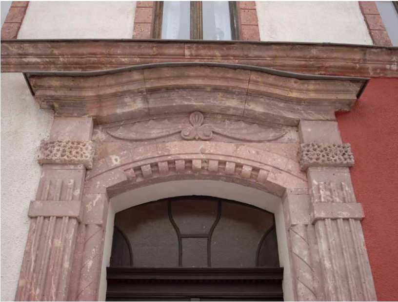
Abb. 12 Portaldetail von einem Gebäude im Ortsteil Hilbersdorf.
