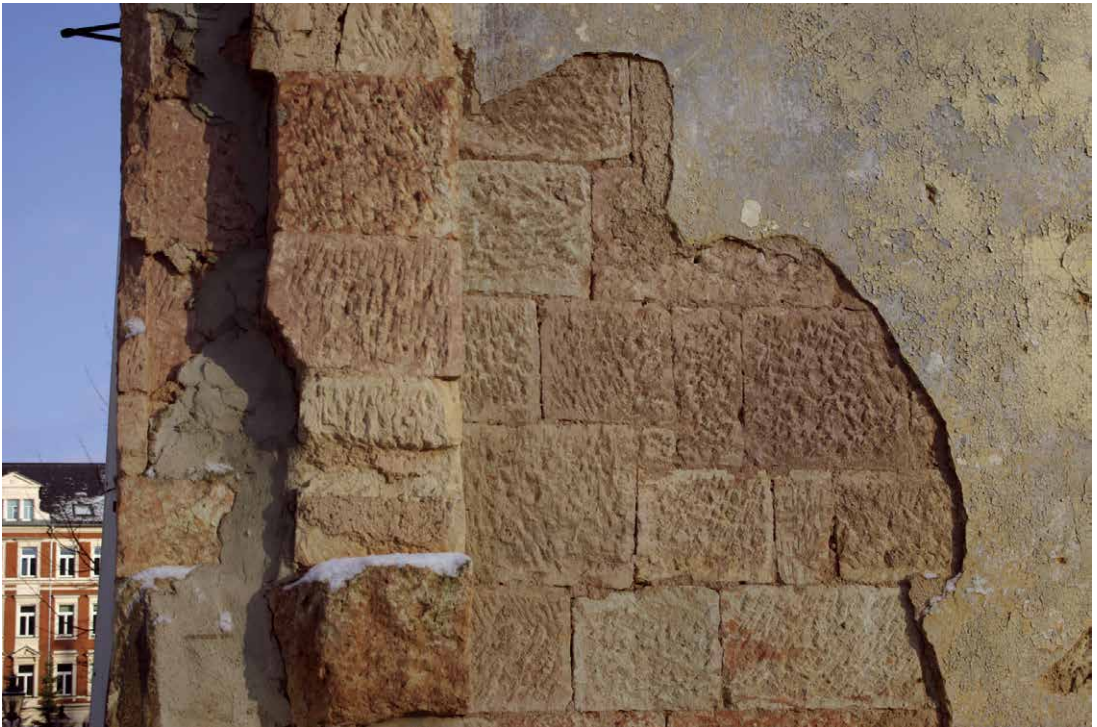
Abb. 3 Mauerwerk aus Hilbersdorfer Tuff unter Putz, Lerchenstraße.
