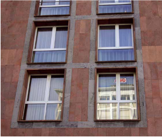
Abb. 16 Fassadengestaltung mit Rohlitzter Porphyrtuff und Theumaer Fruchtschiefer an einem Gebäude an der Straße der Nationen (1961/62).
