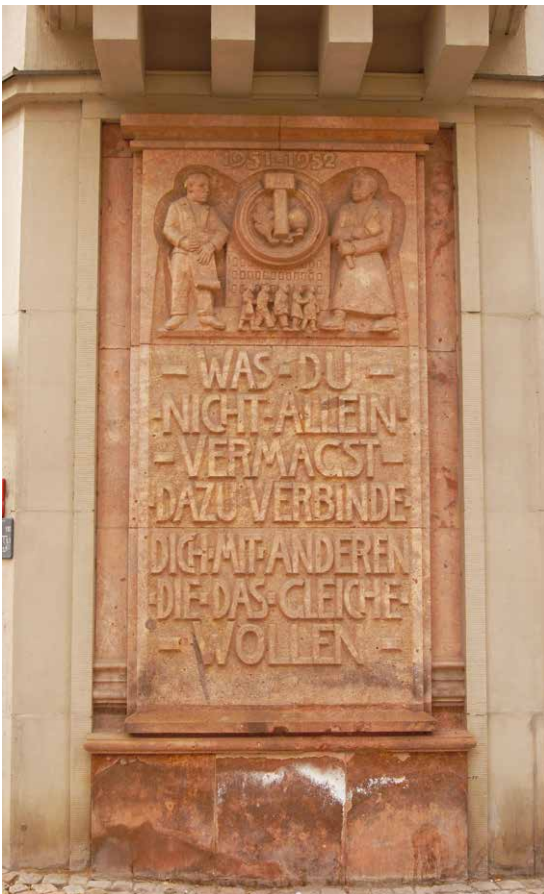
Abb. 16 Fassadengestaltung mit Rohlitzter Porphyrtuff und Theumaer Fruchtschiefer an einem Gebäude an der Straße der Nationen (1961/62).
