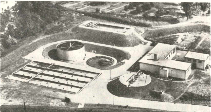
Abb. 8. Kläranlage Goldstein, Frankfurt
