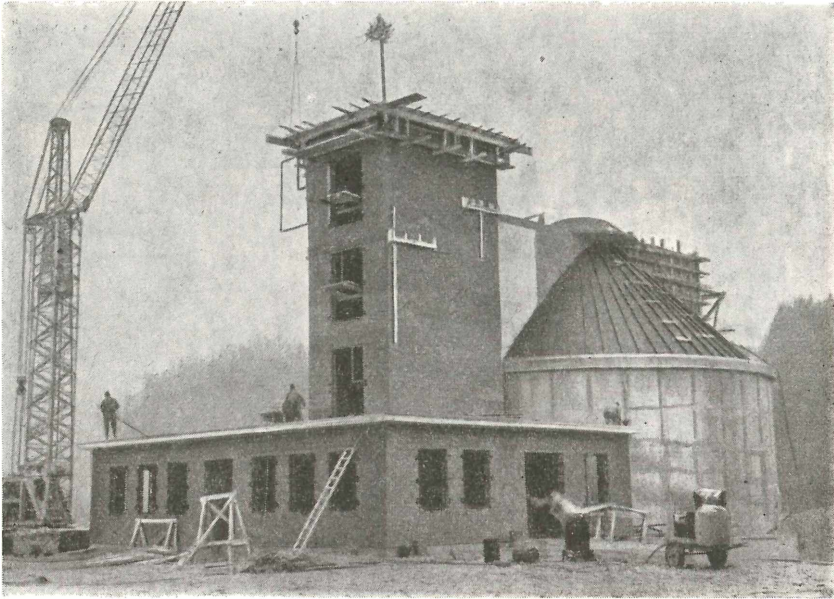
Abb. 9. Schlammfaulbehälter Wels, Bauzustand
