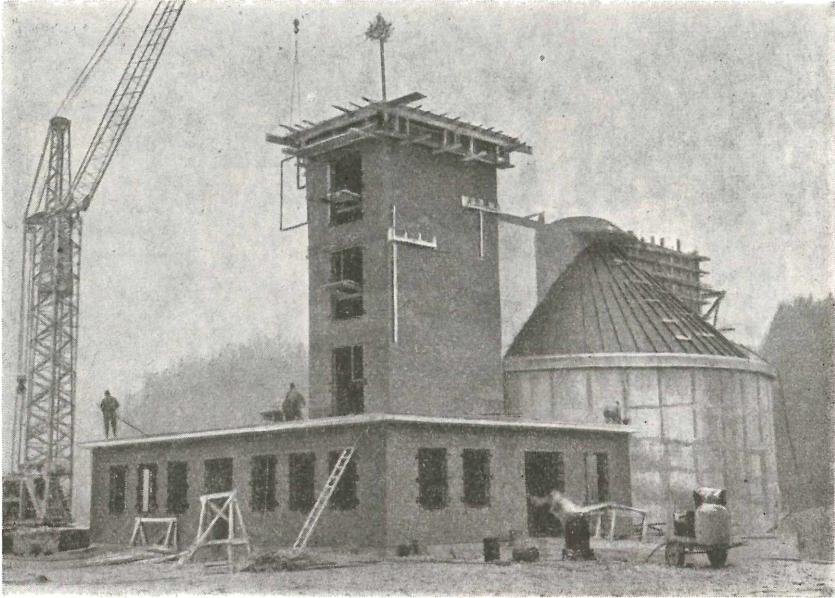
Abb. 9. Schlammfaulbehälter Wels, Bauzustand
