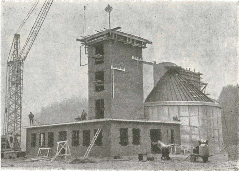
Abb. 9. Schlammfaulbehälter Wels, Bauzustand
