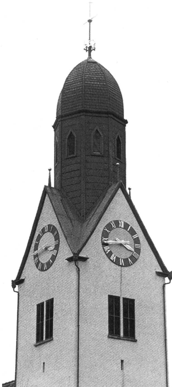
Kirchturm von Otelfingen (erbaut bei der Kirchenrenovation von 1842)
