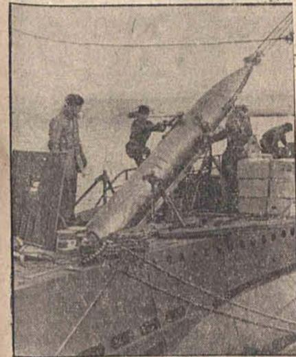
In einem U-Boot-Stützpunkt im Mittelmeer Auffüllen der Munitionsbestände / Ein Torpedo wird übernommen und im Heckraum verstaut (PK-Aufn.: Kriegsberichtler Huck, Atl., Z.)
