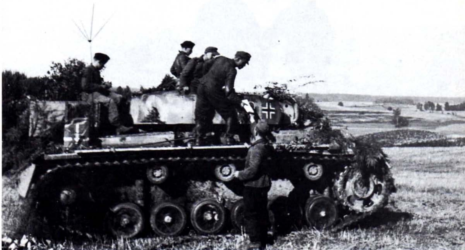
Hier zwei Befehlspanzer III K mit der 5-cm-Kwk L/60. Beide tragen bereits Schürzen, die es, allgemein gesehen erst so richtig bei der Ausführung M gab. Es waren also Nachrüstungen, zumal ja Befehlspanzer länger lebten und nach dem K keine mehr gebaut wurden. Das weiße Kreuz auf dem Spritkanister bedeutet Trinkwasser. (2xBA)
