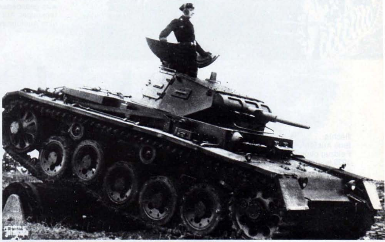
Oben: Typisch für die Ausführung A sind auch die großen Deckel- seiten der Einstiegs Luke an der zylindrischen Komman- dantenkuppel.
