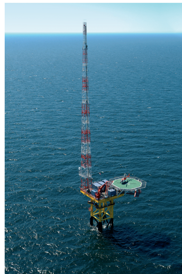
Die Forschungsplattform „Fino“ wurde 2003 in der Nordsee 45 km nördlich von Borkum errichtet.
