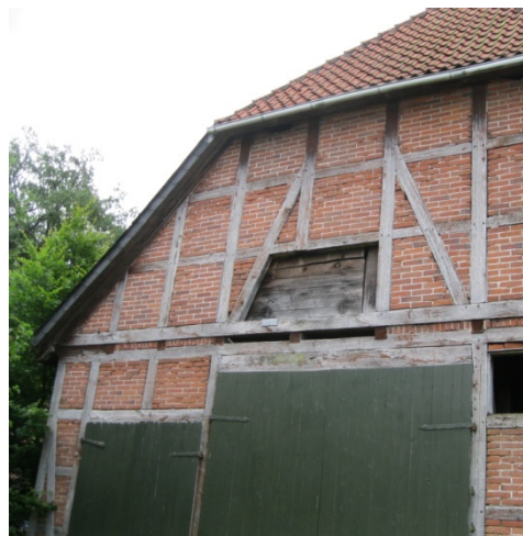
Abbildung 31: Gefachenausfüllung aus Backsteinen
