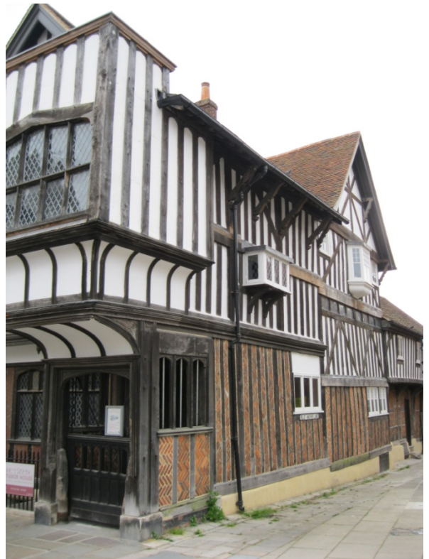
Abbildung 33: Typisches englisches Fachwerk - das Tudor House in Southampton
