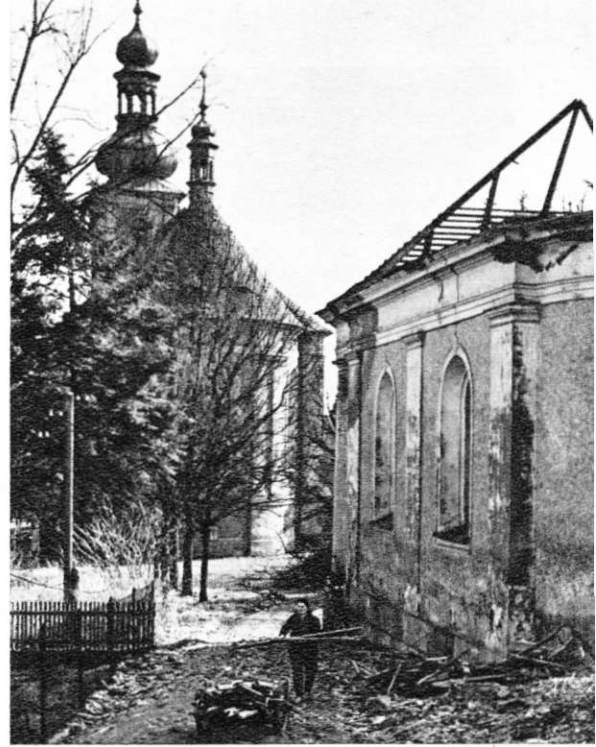
Die bekannte Kapelle hinter der Pfarrkirche in Schönlinde im Niederland. Der Dachstuhl ist eingefallen, und eine heutige Einwohnerin sammelt das vom Dach gefallene Holz für den Ofen.
