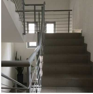
Haupttreppe über alle Etagen
