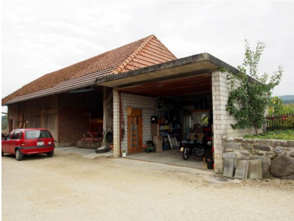
Scheune mit Pferdestall, Remise, Garage
