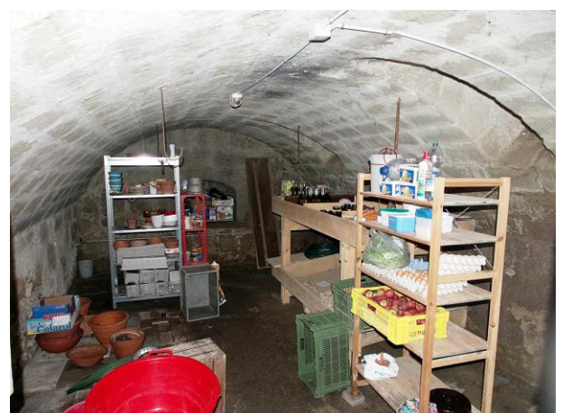
gewölbter Keller unter Wohnteil
