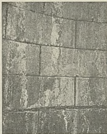
Abb. 5. Ausbau von Schacht Alma 1 in englischen Tübbing, 75 Jahre alt.
