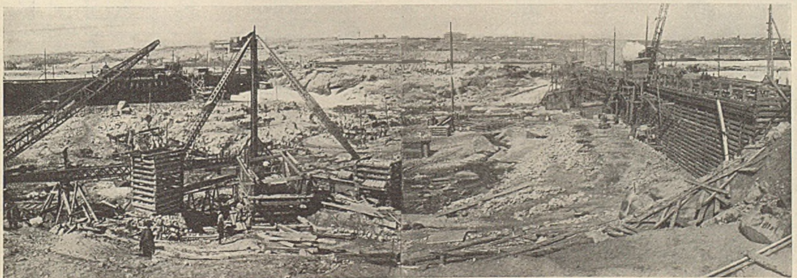
Abb. 2. Gründung der Staumauer.
