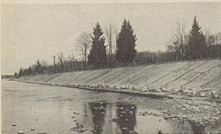
Abb. 8. Betonplatte mit Vorlag- und Granitbruchsteinen von km 49,6 bis km 50,1.
