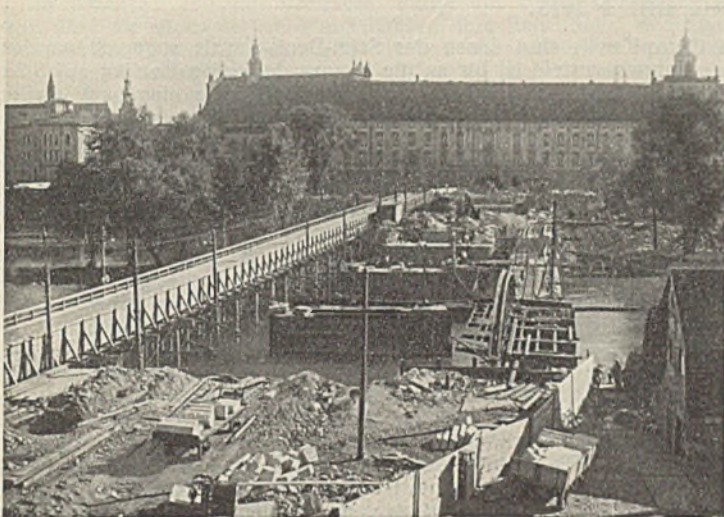
Abb. 17. Blick auf die Baustelle vom nördlichen Brückenkopf.
