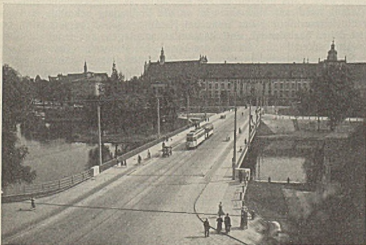
Abb. 19. Blick auf die fertige Brücke vom Nordende.
