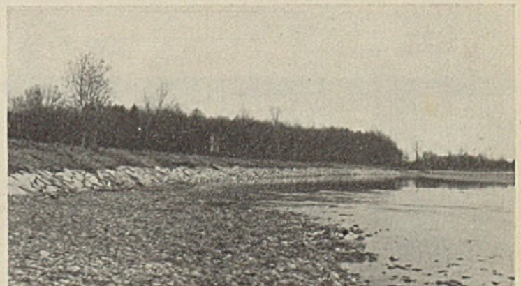
Abb. 9. Versteinungen in Form eines Pflasters aus Betonspaltsteinen.
