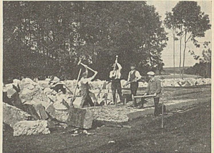
Abb. 2. Illerkorrektion. Herstellung von Betonspaltsteinen.
