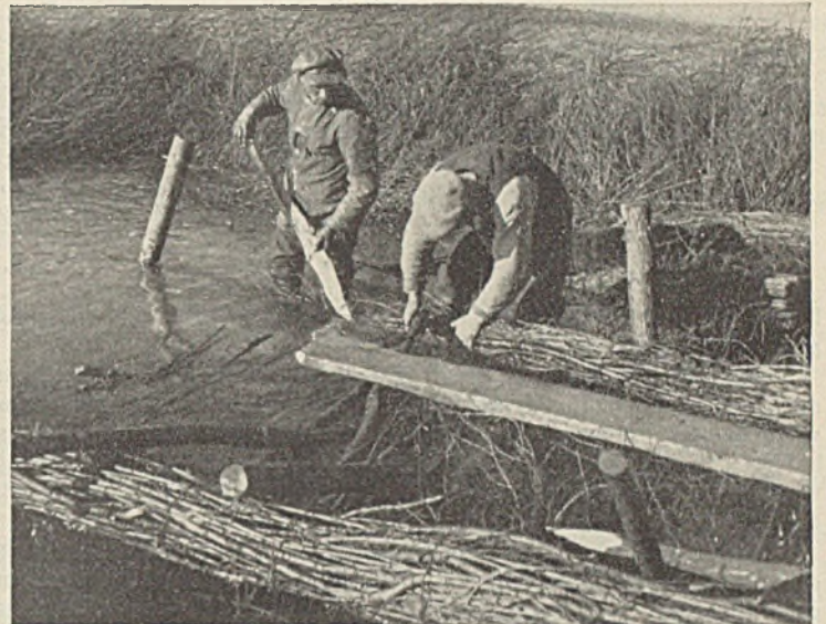
Abb. 17. Lechbruck—Illach. Faschinenarbeit beim Zuschußbau.
