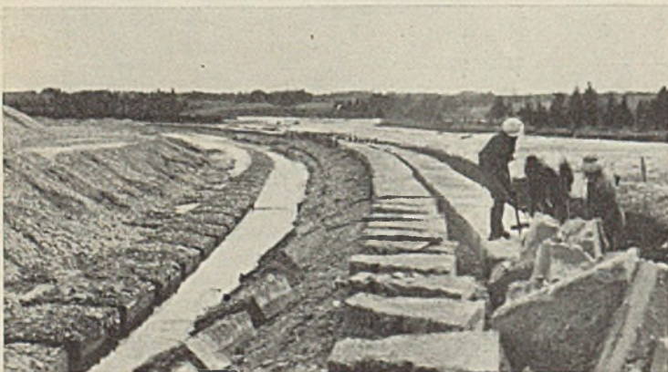
Abb. 14. Sicherung der Böschung. Durch Vorlegen der gespaltenen Betonsteine am Böschungsfuß sind Betonvorreiter vorgelegt.
