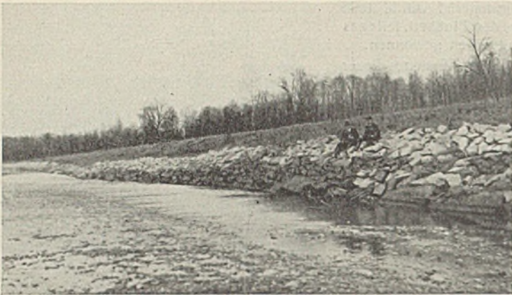
Abb. 10. Versteinerung durch Berollung aus alten Granitbruchsteinen und neuen Betonspaltsteinen.
