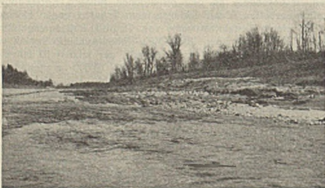
Abb. 3. Flinzbank bei km 47,5 vor Inangriffnahme der Bauarbeiten.
