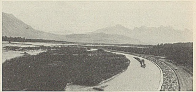
Abb. 13. Lechkorrektur Füssen—Deutenhausen zwischen km 158 und 159.
