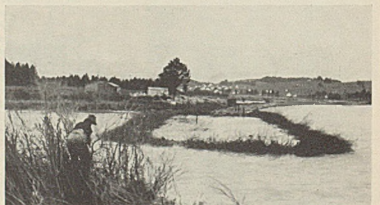
Abb. 15. Faschinenarbeiten am Schöpfkopf bei der Verlandungsöffnung. Blick flußaufwärts.
