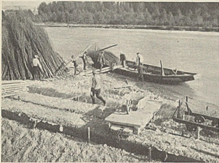
Abb. 16. Der neue Damm.
