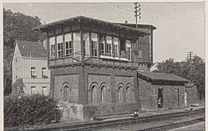
Abb. 9. Häßliches älteres Stellwerk an einer Rheinstraße. Man beachte die unzweckmäßigen schrägen Eckfenster und die Überschneidung von Fenstern durch Abfallrohre
