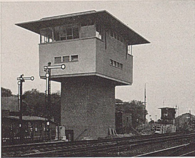
Abb. 4. Elektrisches Vierreihenstellwerk. Ziegel-Unterbau nach Profil eingeschränkt.
