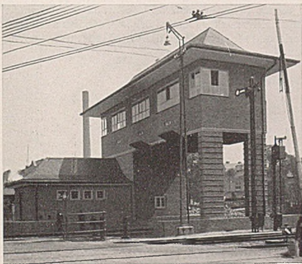
Abb. 23. Reiterstellwerk aus Ziegeln mit Schieferdach um 1929.
