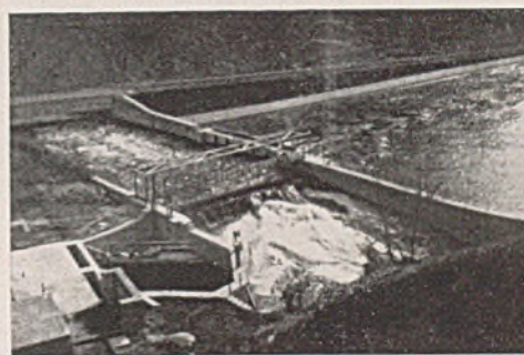
Abb. 7. Wehr und unteres Becken in Pastra.
