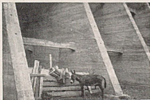
Abb. 5. Pfeiler des Kamenitza-Beckens.
