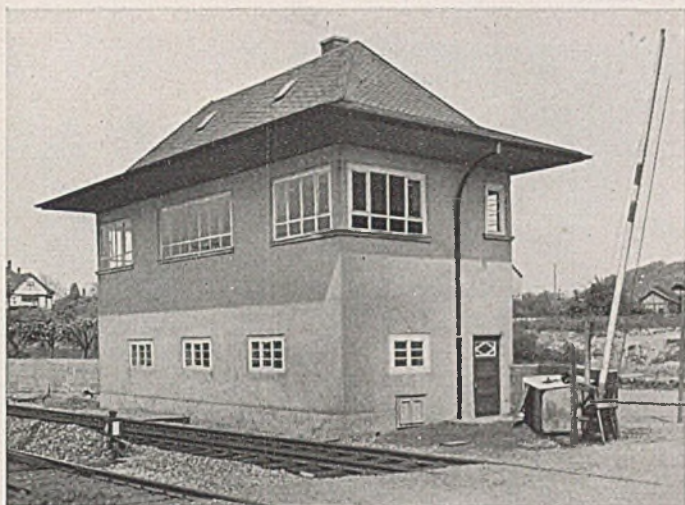
Abb. 10. Stellwerk (Putzbau) von 1930 mit Schrankenbedienung.
