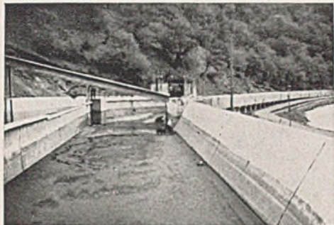
Abb. 2. Obergraben und oberes Klärbecken der Zentrale Pastra.
