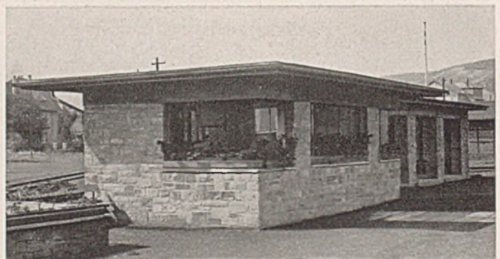
Abb. 21. Stellwerk in Verbindung mit Wartehalle auf einem Bahnsteig.
