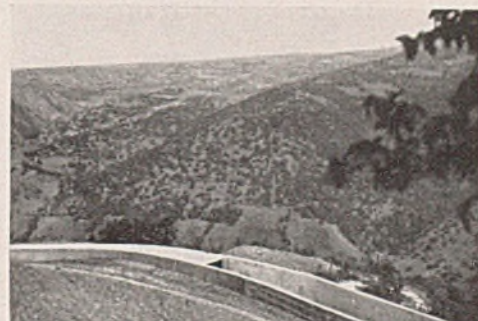
Abb. 8. Wasserschloß der Zentrale Rila; obere Kammer.
