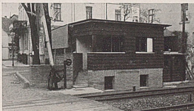
Abb. 14. Schrankenwärterposten. Holzwerk mit Karbolineum gestrichen. Öffnungen rot abgesetzt.
