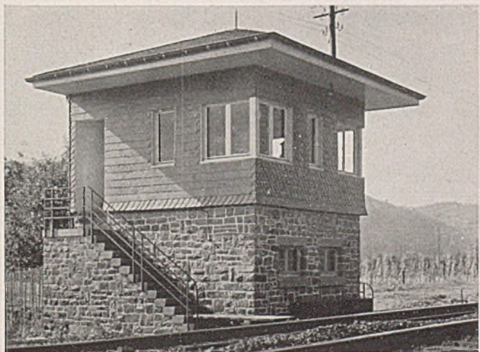
Abb. 12. Blockstelle im Rheintal von 1935.
