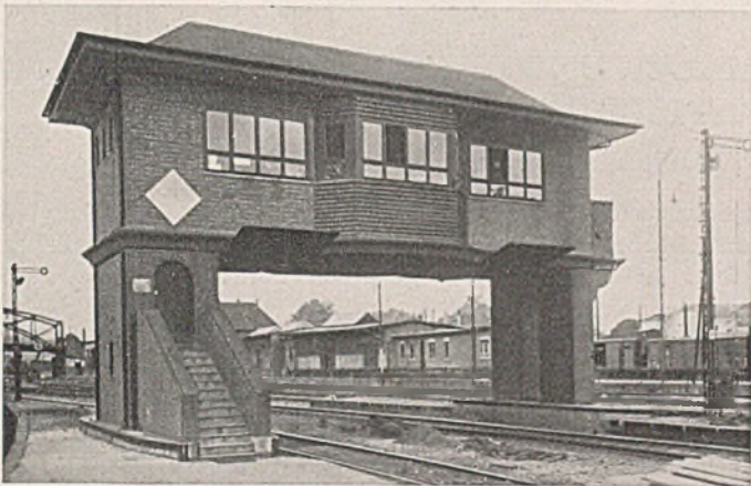
Abb. 22. Reiterstellwerk in Ziegelausführung mit Schieferdach (schwere Unterbauten) um 1926.
